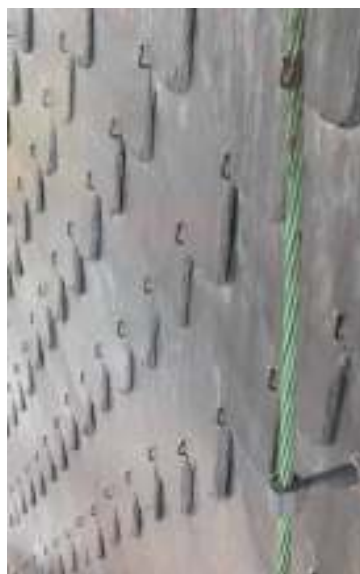
Foto från rivning av spirans kopparplåt och detalj av ny skiffer med stormklammer.
