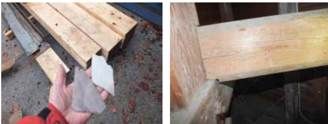
På långbusvinden funna rester av ursprunglig takskeffer och inskription på bjälke i tornet.
