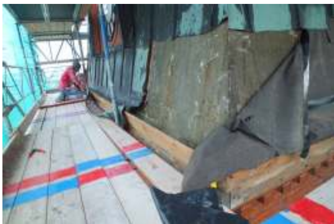
Foto från rivning av spirans kopparplåt och detalj av ny skiffer med stormklammer.
