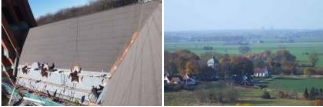
Foto av påbörjad skiffertäckning på långhuset och utsikt mot Västra Sallerups medeltida kyrka.
