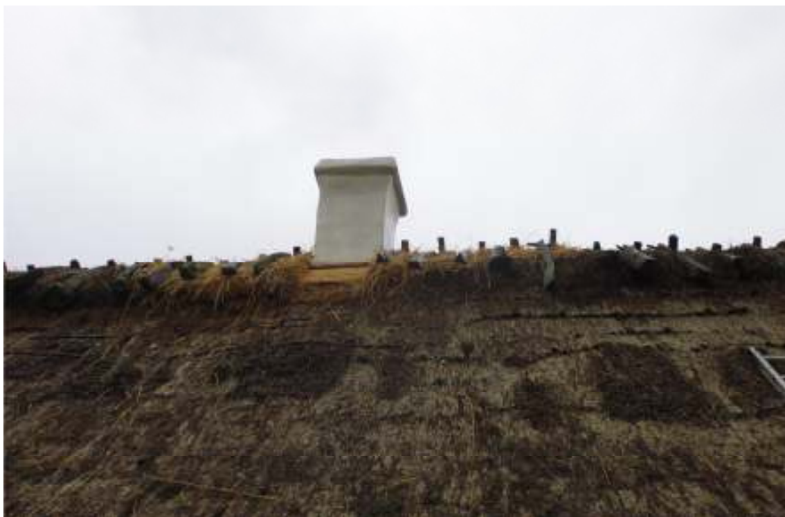
Södra takfallet, efter arbetet.
