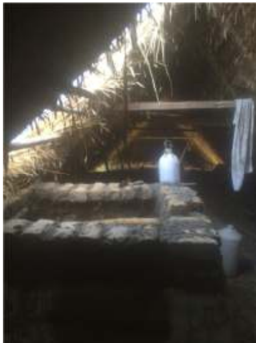
Uppmurning av murstock påbörjad.
