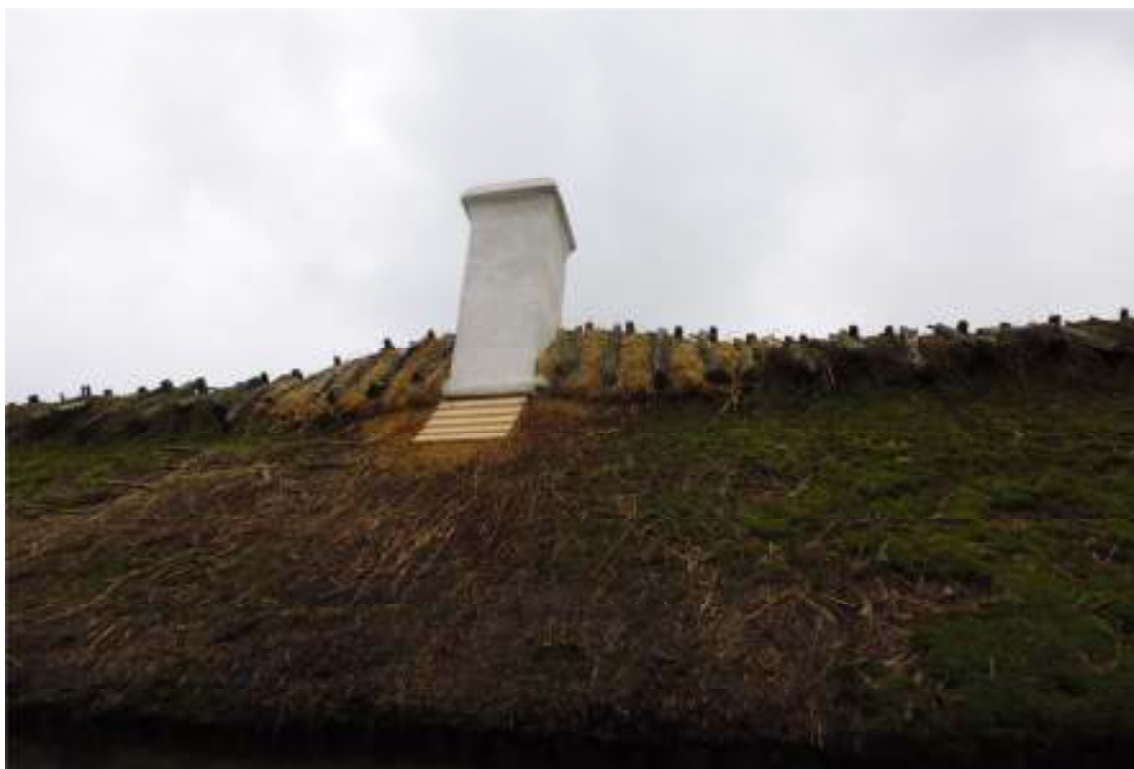
Norra takfallet, efter arbetet.
