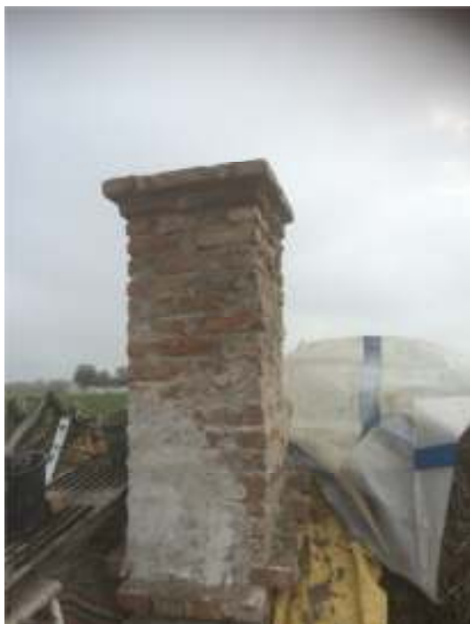
Putsning av skorsten påbörjad.
