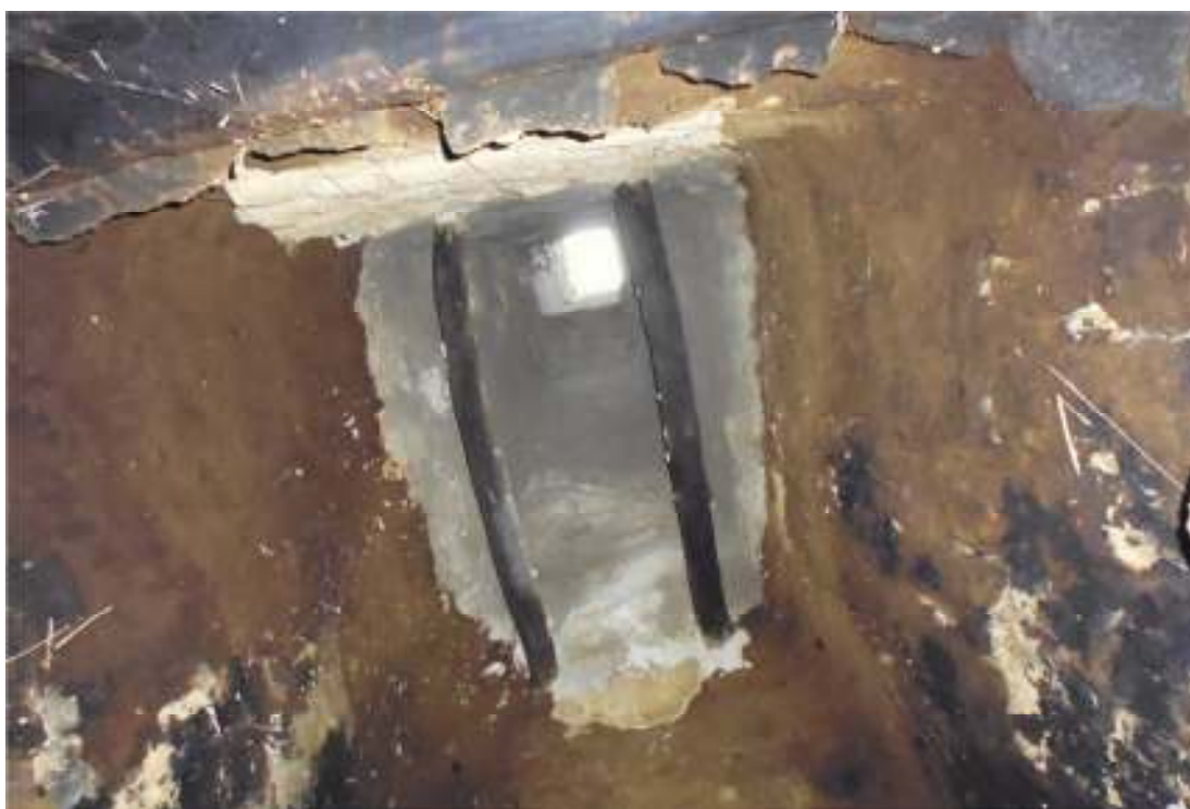
De återsatta träslanorna. Ljusgrå parti utgör den nya invändiga lerputsens.
