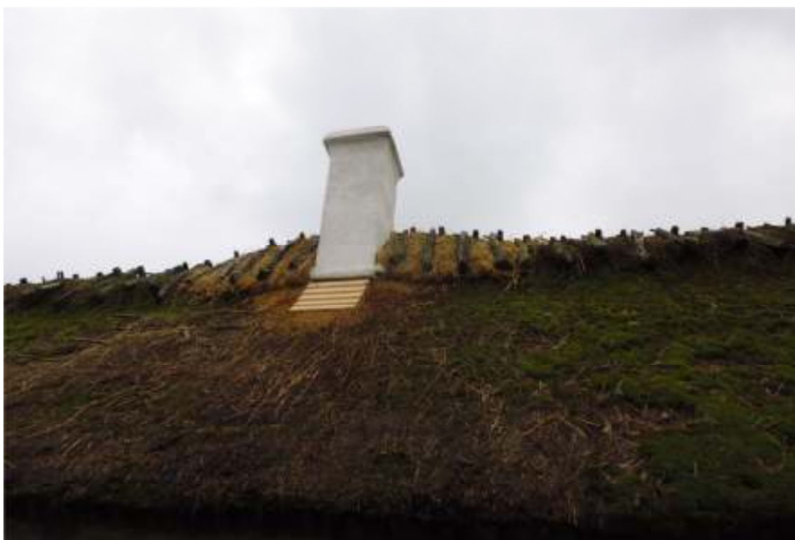
Norra takfallet, efter arbetet.
