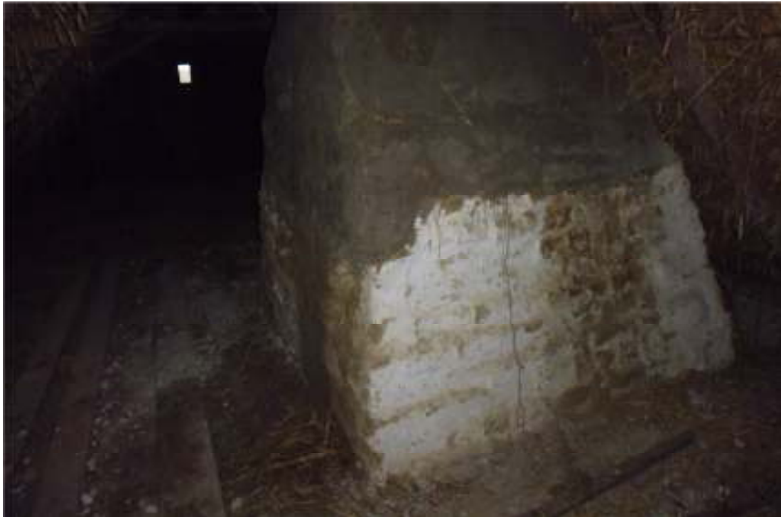
Murstocken sedd från vinden, efter arbetet.
