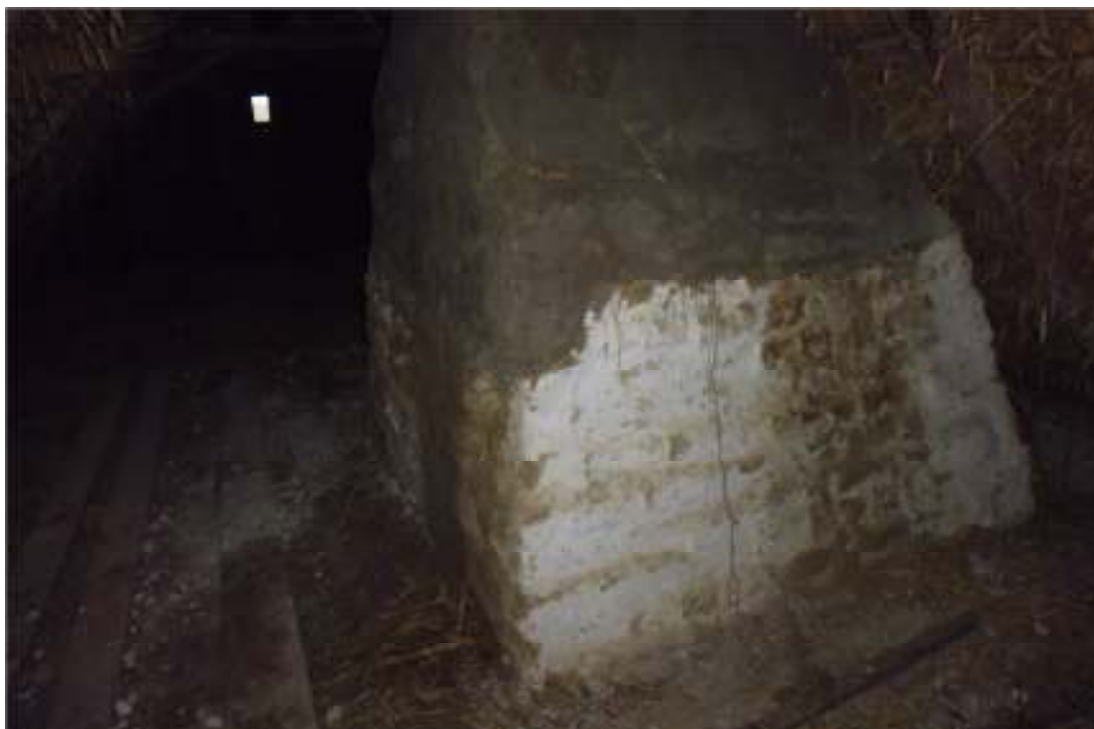
Murstocken sedd från vinden, efter arbetet.
