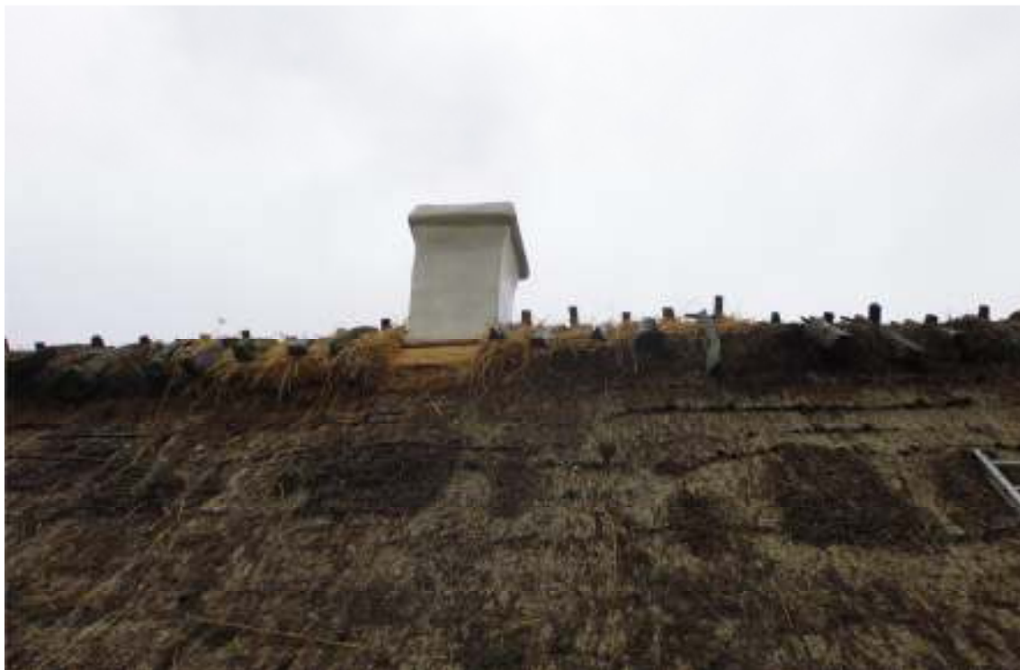
Södra takfallet, efter arbetet.
