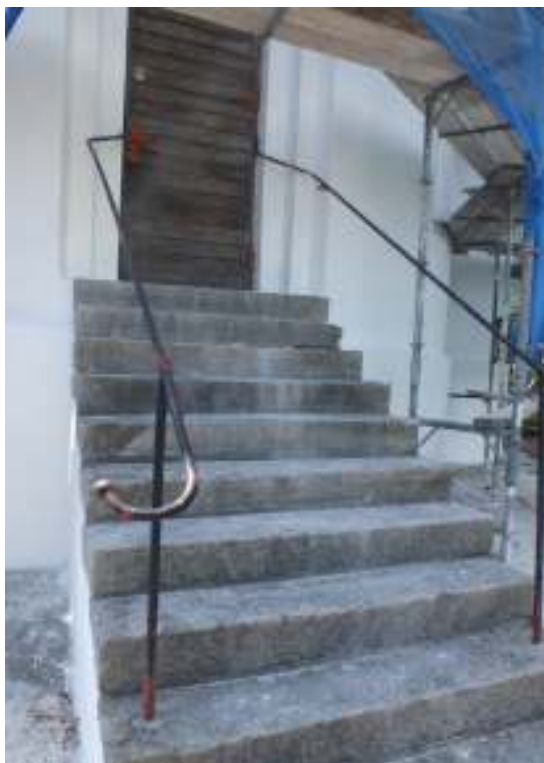
Absidens dörr, t.v. före ytbehandling och t.h. efter oljning av trädörren och avfärgning av trycke och räcke.
