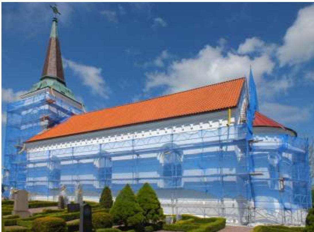
Hassle Bösarps kyrka under fasadrenoveringen, maj 2014.
