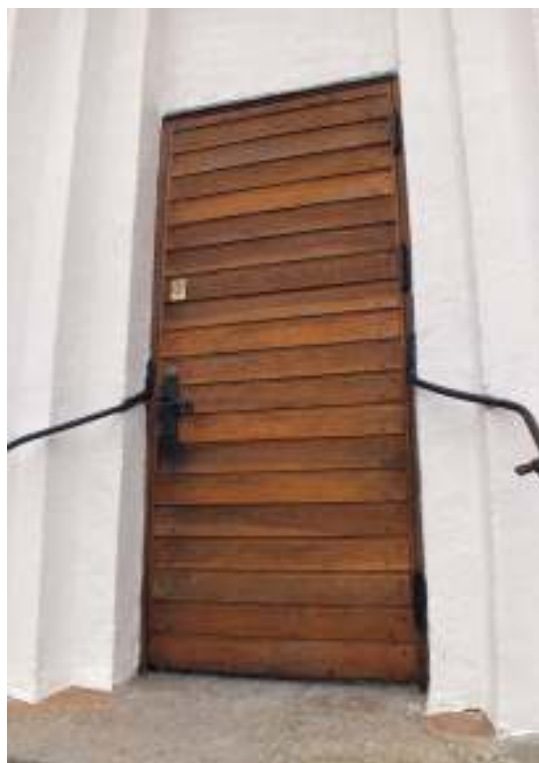
Absidens dörr, t.v. före ytbehandling och t.h. efter oljning av trädörren och avfärgning av trycke och räcke.
