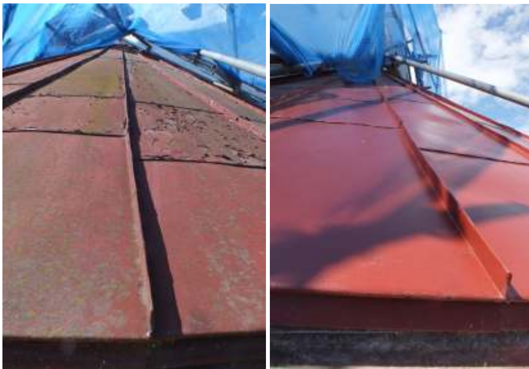
Absidetakets före och efter målning. Taket rengjordes, skrapades och avfärgades med "Pentur Solo".
