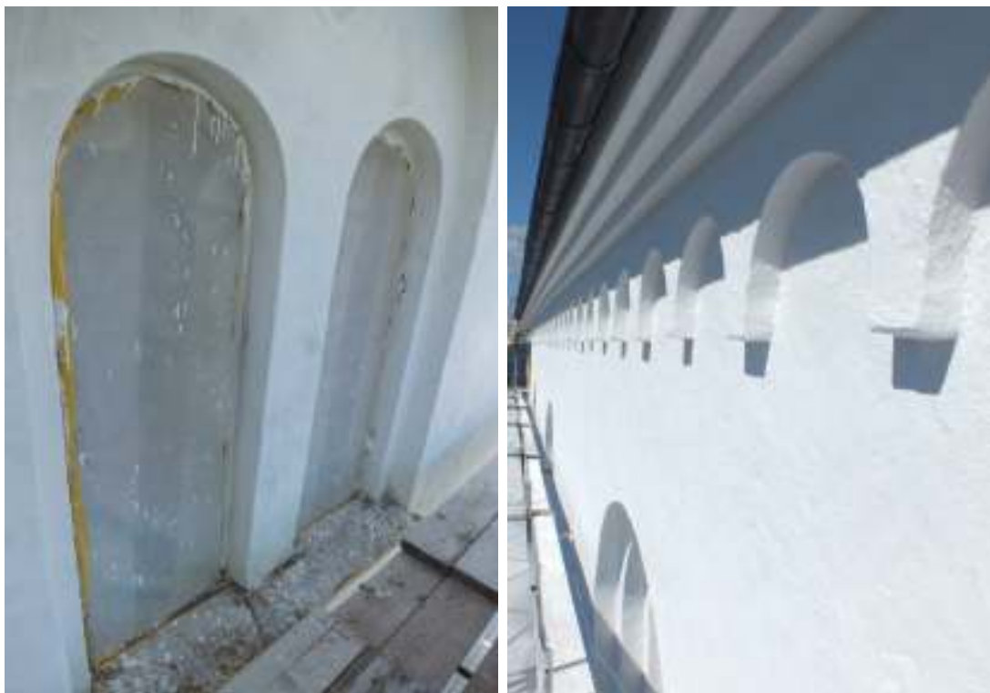
T.v. tornet som avfärgats en gång med hydraulit och t.h. långhusets södra fasad som avfärgats två gånger med samma färg.
