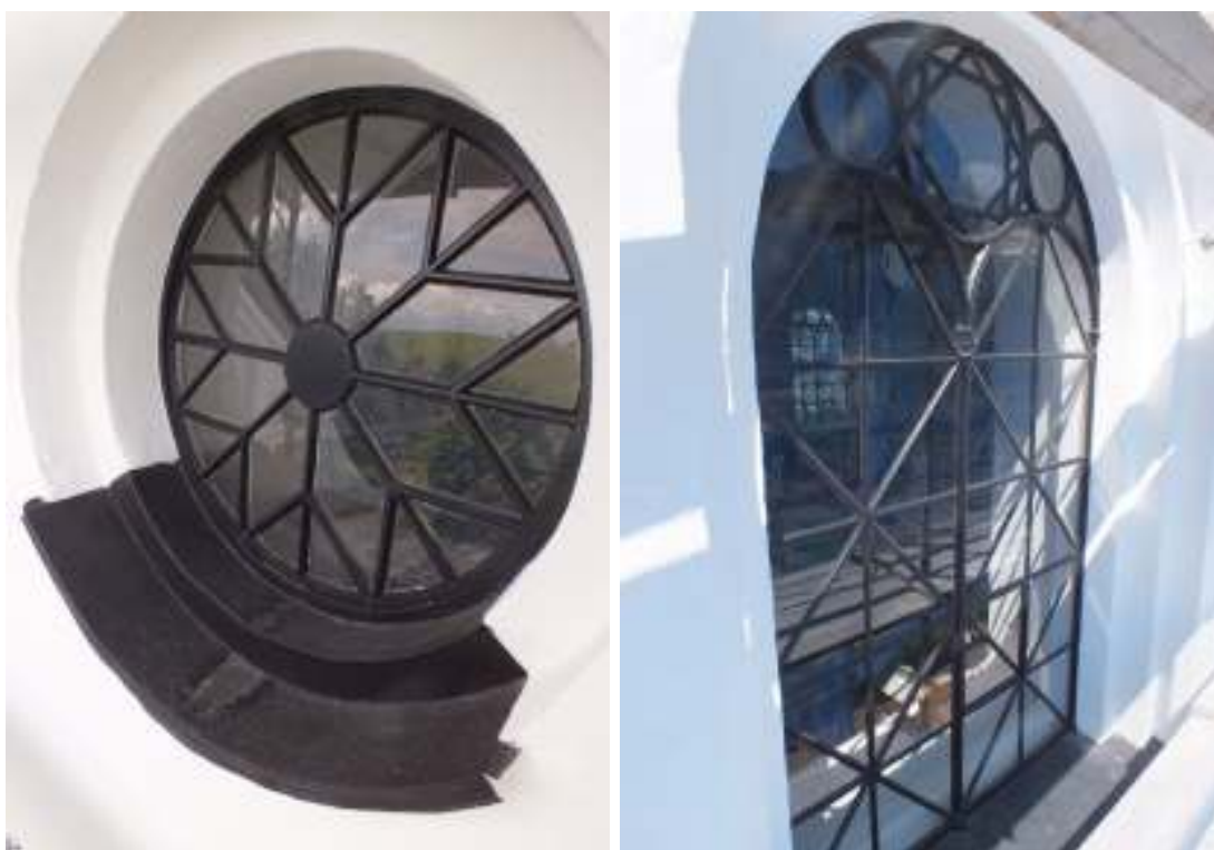
Långhusfönster och tornfönster, efter att de avfärgats med järnoxidsvart linoljefärg från Engvall o. Claesson.
