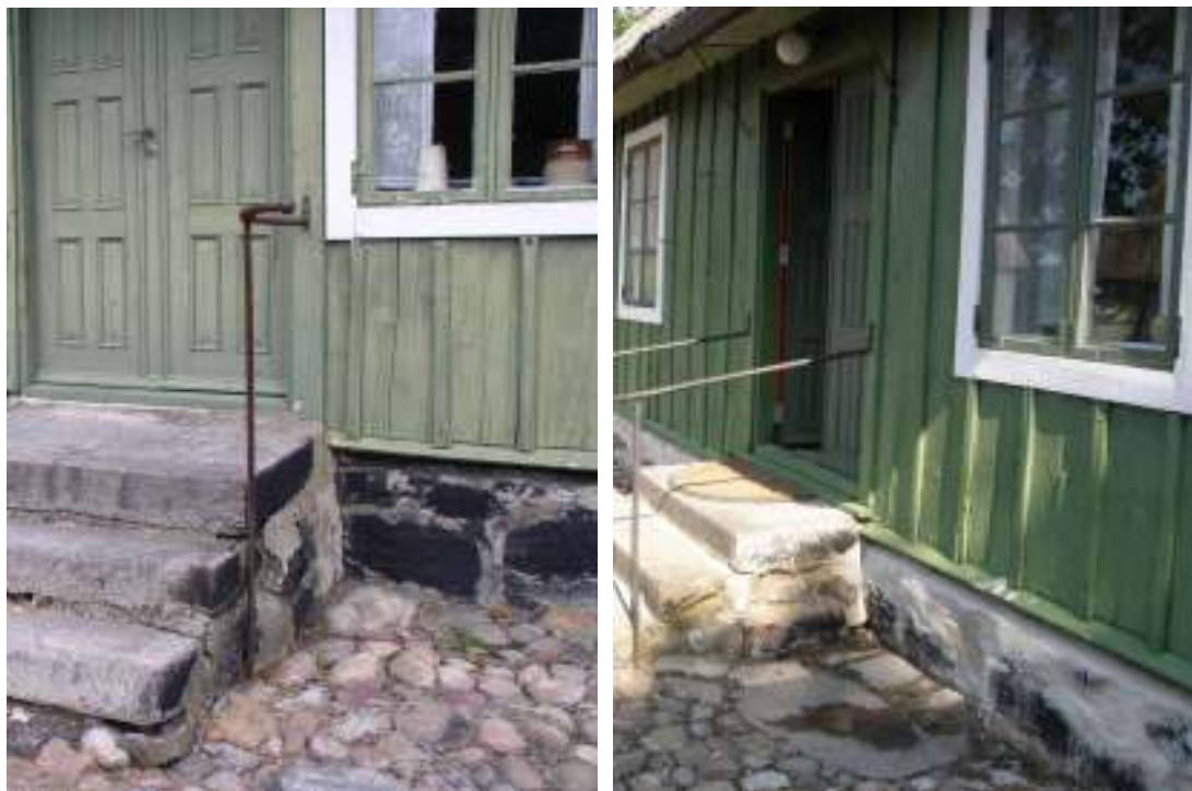
Boningshusets grund före och efter foglagningen, t v ses grunden vid förstugans trappa och th kökstrappan. Bilden till vänster är tagen i augusti 2006, före ommålningen av fasaden.
