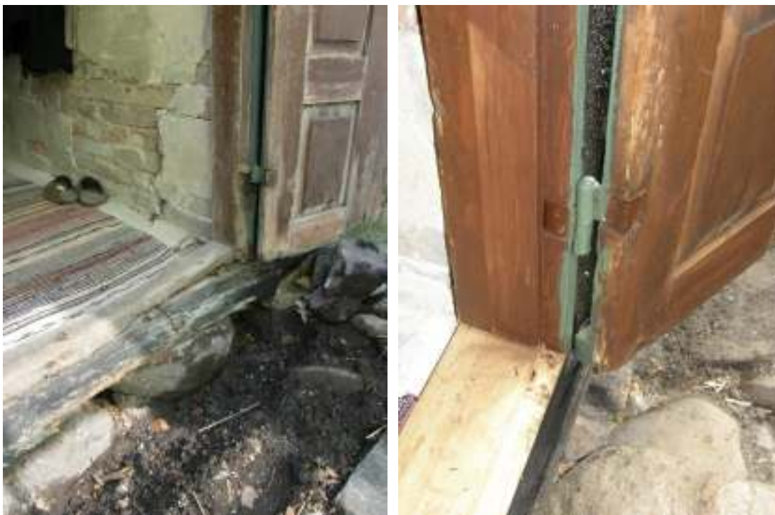
Den norra spegeldörren till brygghuset. Syll, tröskel och en del av karmsidostycket byttes, t v före och t h efter lagningen.
