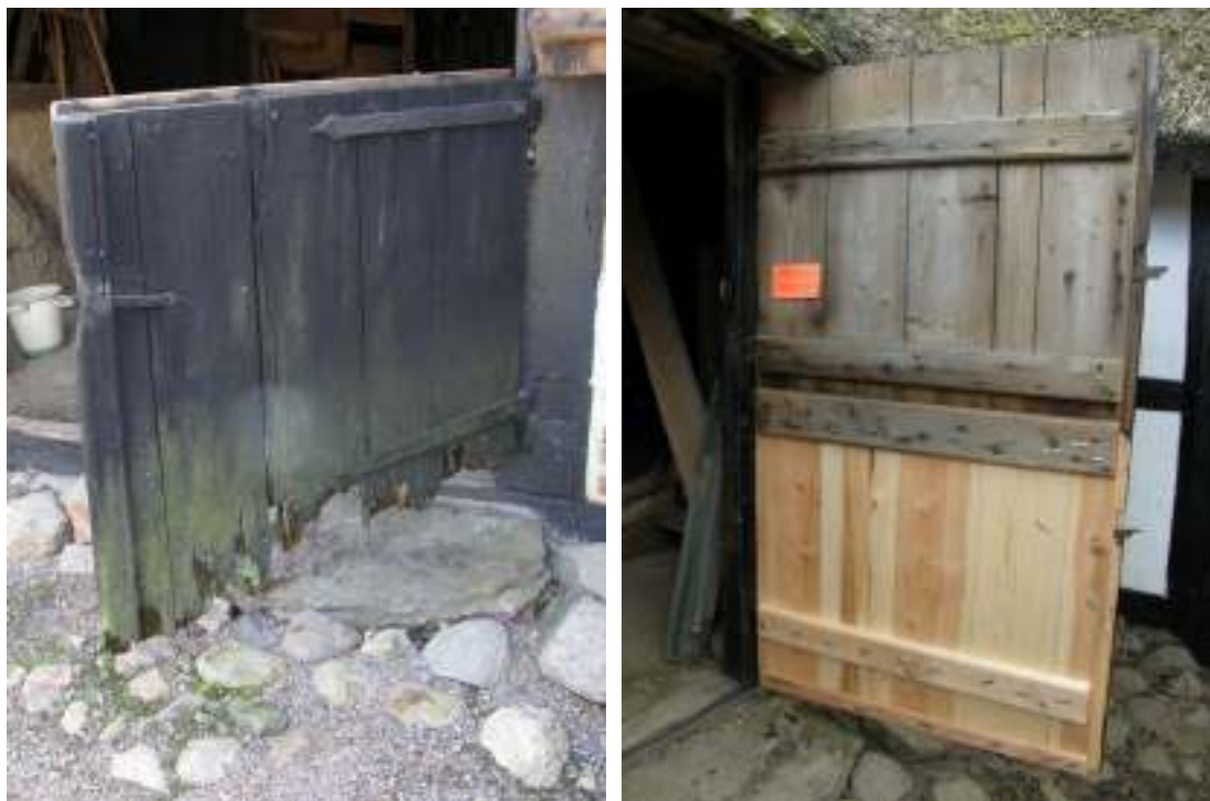
Den södra porten närmast hörnet på logdelen. Det nedre högra dörrbladet byttes mot ett nytt i fur och med samma dimensioner.
