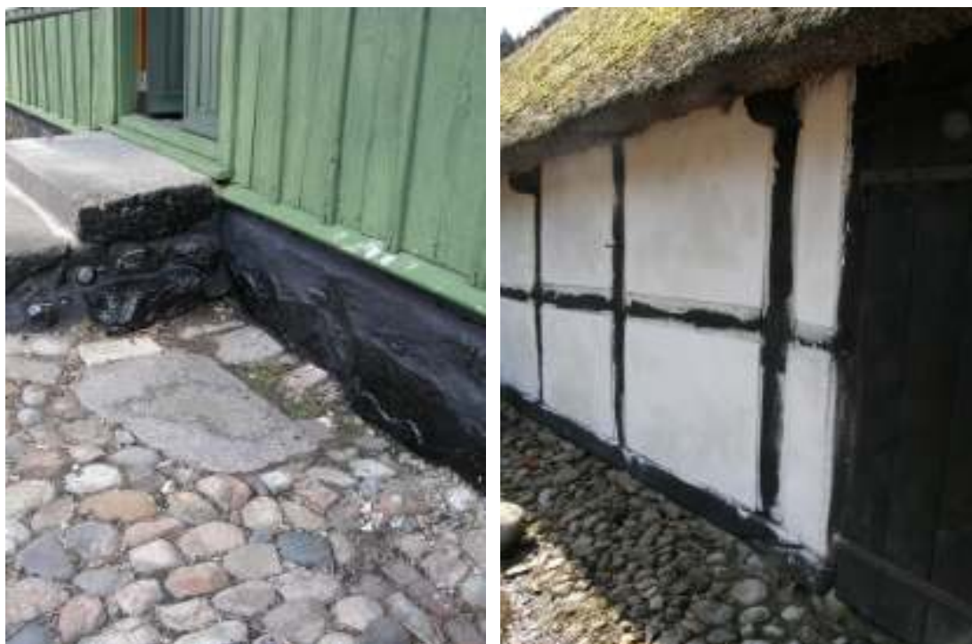
T v boningshusets grund efter avfärgning med stenkoltjära och t h logens gårdsfasad efter putsning och kalkning.
