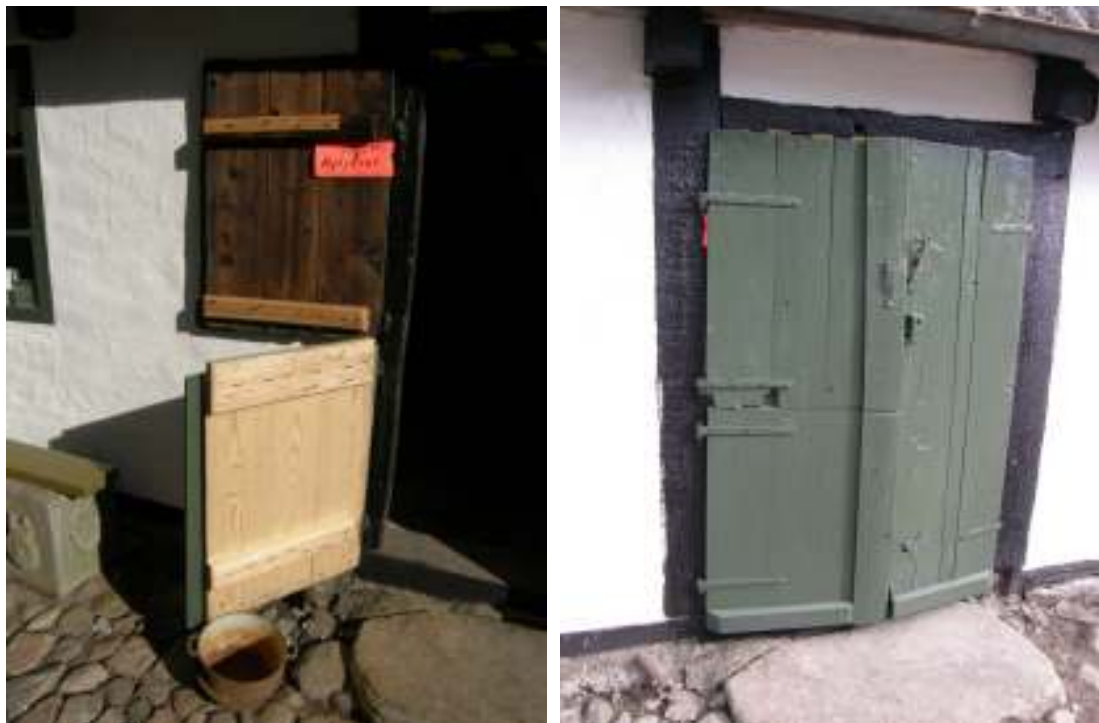
Den mellersta bryggbusdörren efter att det ena bladet nytillverkats (t v), vattbrädor satts på och att dörren målats med linoljefärg i vagnsgrönt (t h).
