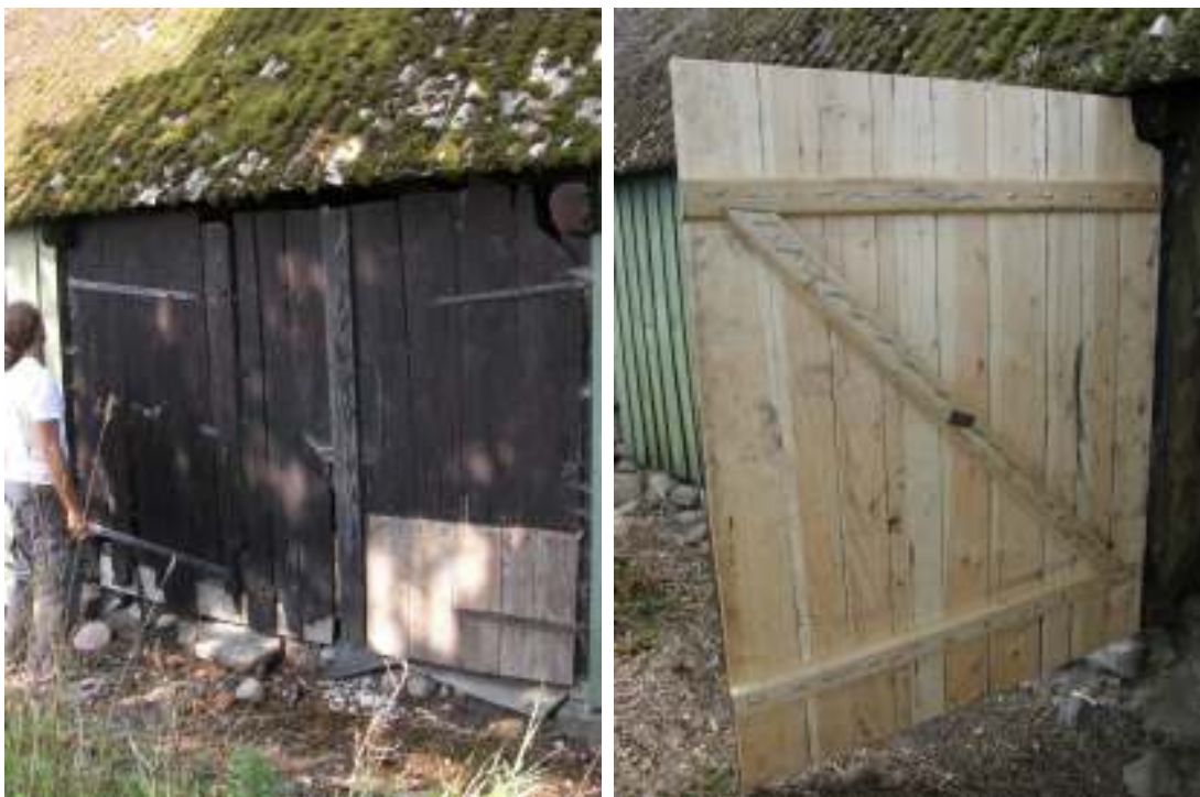
Vångporten på den sydöstra sidan av gårdens utsida, t v före bytet av det vänstra dörrbladet och t h efter.
