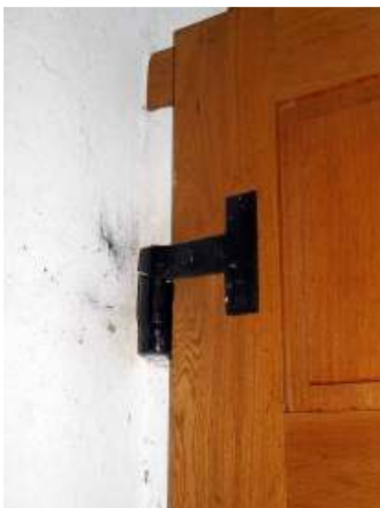
Till vänster syns den nya murstapeln på ytterdörren med påsvetsad tapp. Notera att tappen är diagonalt skuren upptill vilket ger dörren en självstängande funktion. Till höger syns innerdörrens ombägning på en bricka vilket lyfter upp dörren en centimeter från golvet.
