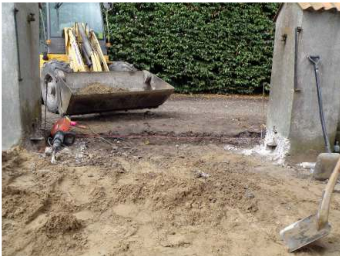
Grindöppningen efter borttagning av den gjutna trappan.
