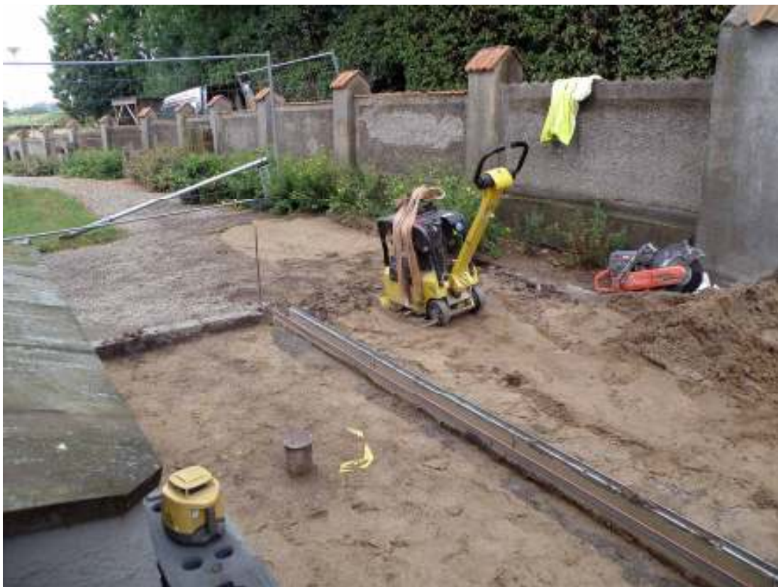
Markbeläggnings framför kyrkan är borttagen och acodrain-rännan är på plats. Upptill i bild syns placeringen av stenkistan intill kyrkogårdsmuren (parti med ljusare sand). Det uppstickande röret ungefär mitt i bild är till för julgranen.
