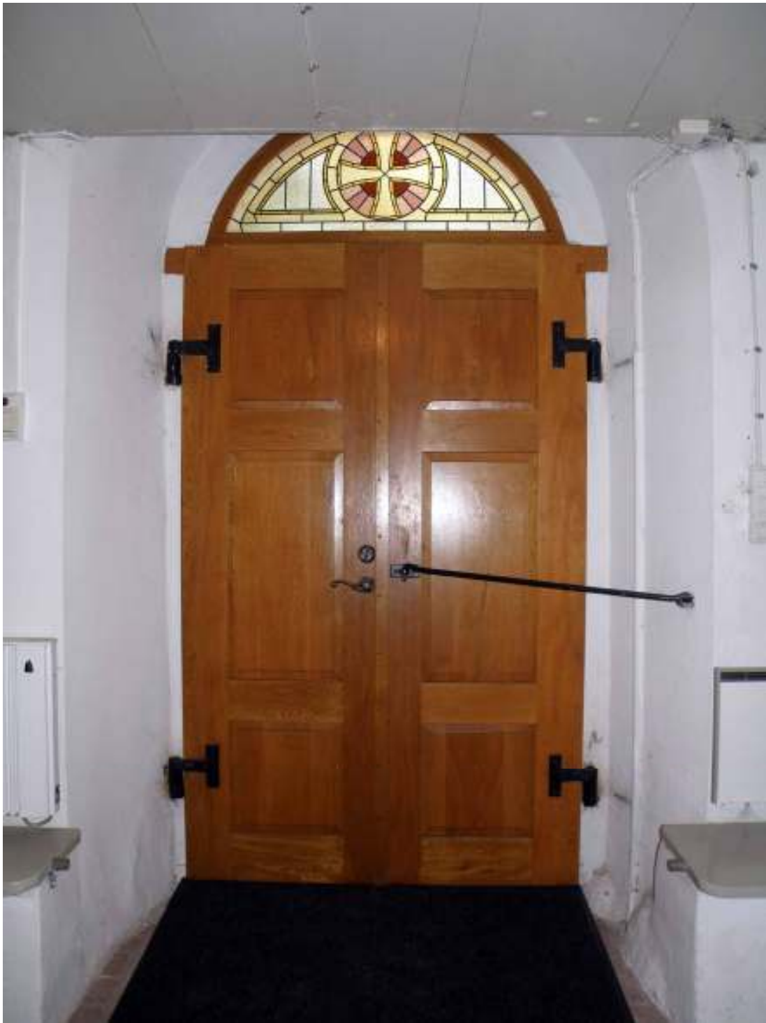
Västra dörrens insida efter utförd renovering.
