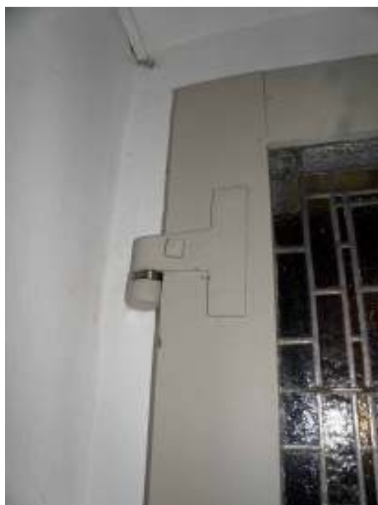
Till vänster syns den nya murstapeln på ytterdörren med påsvetsad tapp. Notera att tappen är diagonalt skuren upptill vilket ger dörren en självstängande funktion. Till höger syns innerdörrens ombägning på en bricka vilket lyfter upp dörren en centimeter från golvet.
