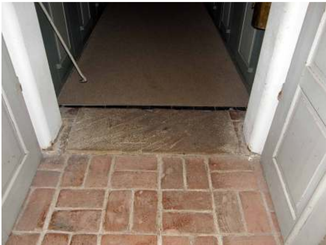
En mindre tröskel fanns före arbetets början vid innerdörren mellan vapenhus och långhus.
