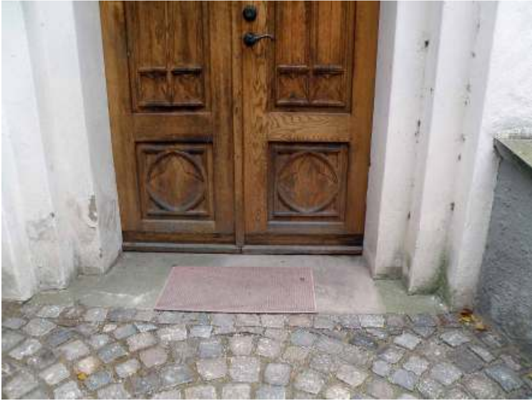
Dörren före utförd renovering.
