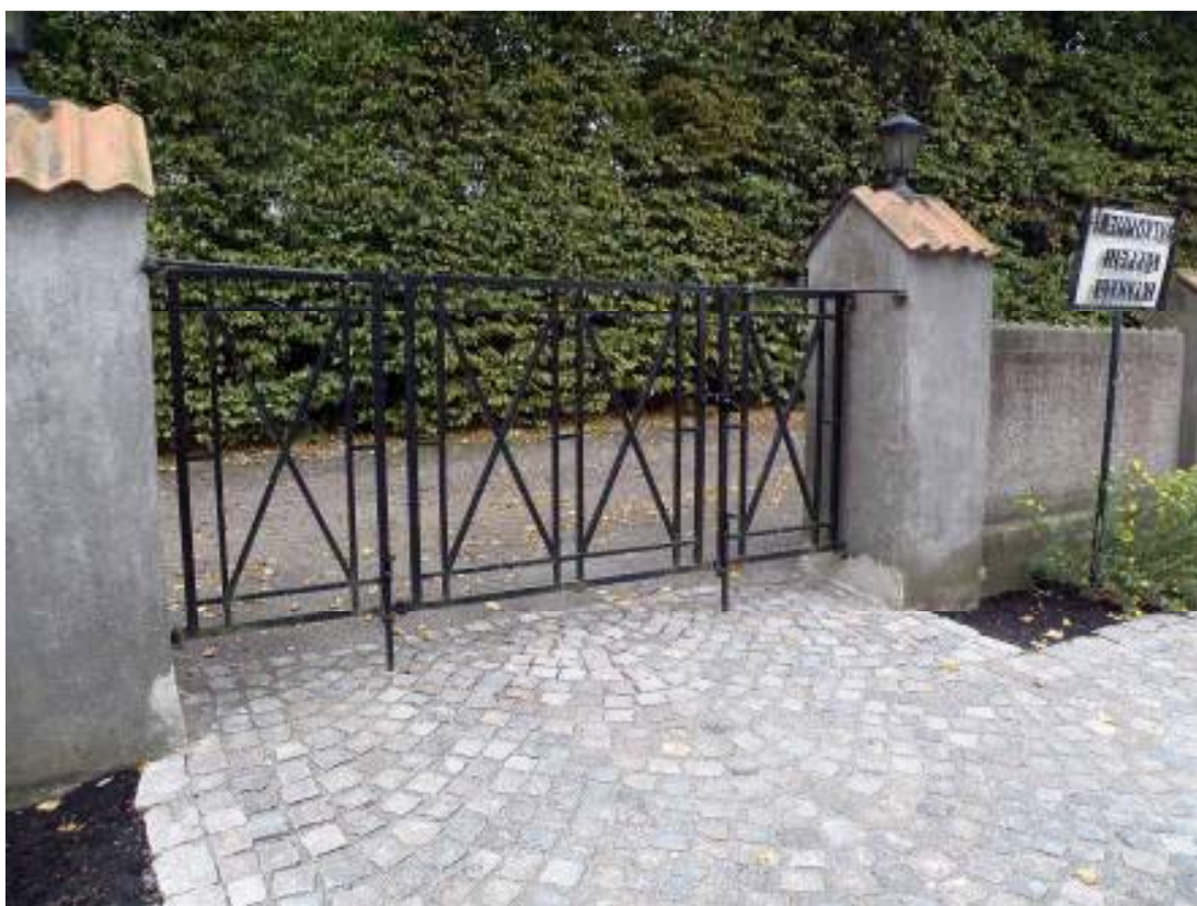
Grindparti och ny markbeläggning efter utförda åtgärder. Trappstegen vid grindöppningen togs bort vilket gjorde att grindens nedre parti hamnade högre över marken. Tapparna i nederkant fick förlängas. Istället för den gamla haspen uppe på grindens övre kant gjordes ett handtag längre ned på grinden. Markbeläggningen från grind till kyrkans entré lades om med samma mönster som tidigare.
