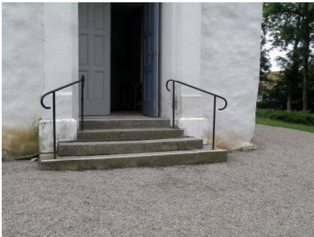
Entrén till kyrkan före anläggandet av rampen.
