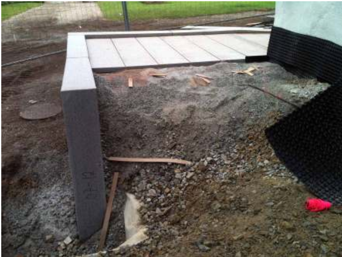
Rampen under uppbyggnad. Rampen byggdes upp av schaktmassor samt makadam. En platonmatta lades som isolering mot tornmuren. Rampens plattor lades på plats i stensmjöl.
