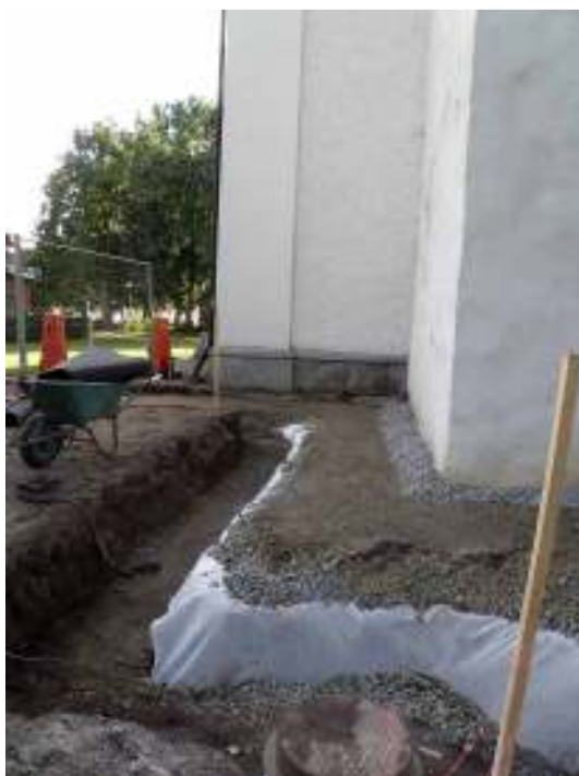
Rännan för sidomurarna sett från väster. Till böger sätts sidomurarna på plats i rännan.
