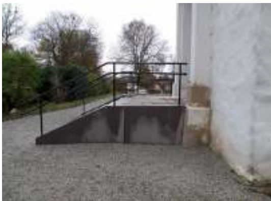
Portalomfattningens södra sida var sprucken och putslagades. Till höger syns räckets infästning i sidomurarna till den nya trappan.
