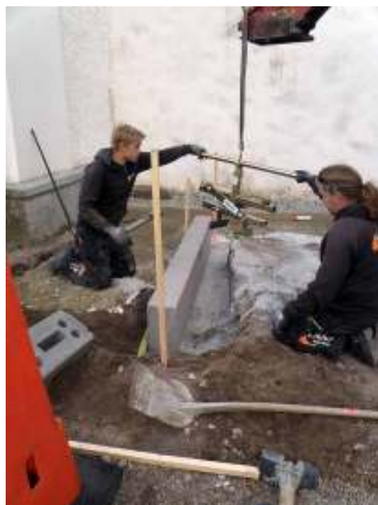
Rännan för sidomurarna sett från väster. Till böger sätts sidomurarna på plats i rännan.
