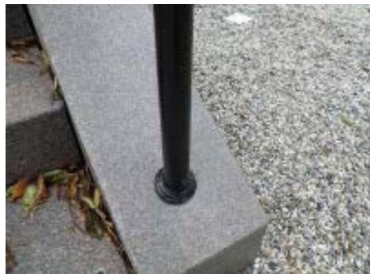
Portalomfattningens södra sida var sprucken och putslagades. Till höger syns räckets infästning i sidomurarna till den nya trappan.
