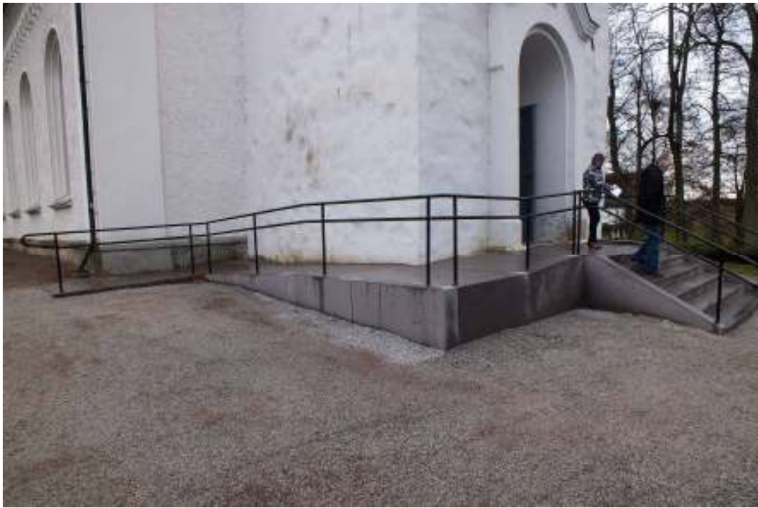
Den nya rampen och trappan i november 2012.
