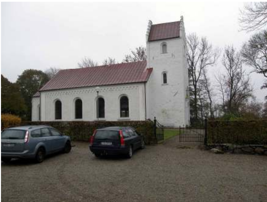
Västra Hoby kyrka sedd från norr före utförda åtgärder.
