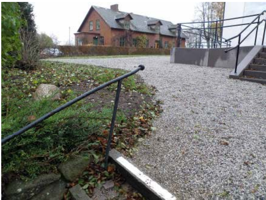
Räcket till trappan gjordes något grövre än det förutvarande räcket men efter inspiration från befintligt räcke i västra kyrkogårdstrappan.
