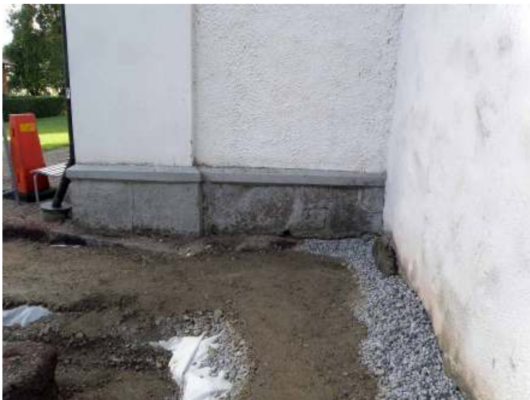
Rampen under uppbyggnad vid tornets nordöstra hörn. En ränna gjordes för sidomuren och makadam lades under rampen på en geotduk.
