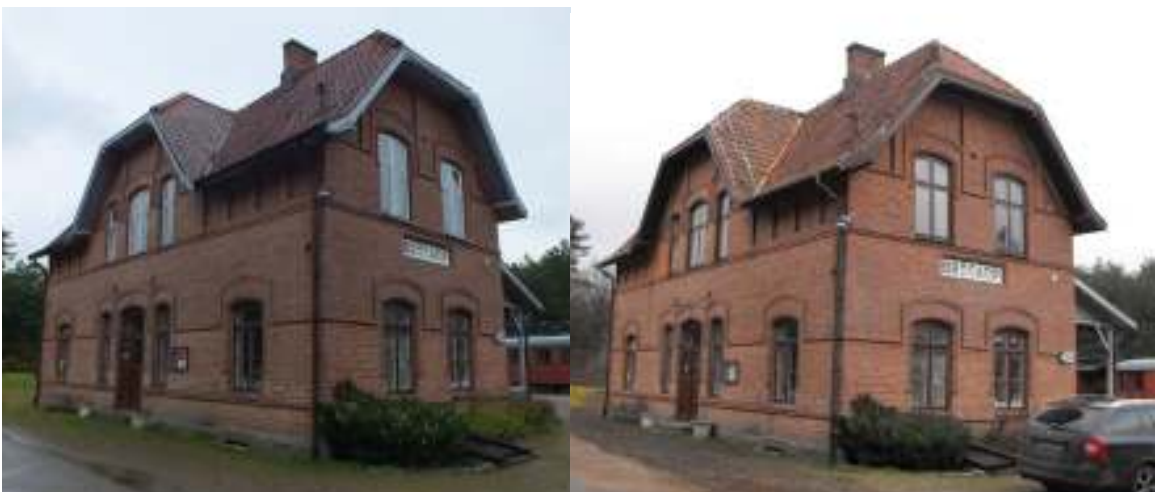
Stationsbyggnadens västra takfall, med frontonen, före och efter takrestaurering-
