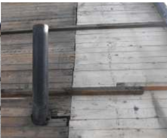
Tidigare lagning av underbrädning vid taksprång.
