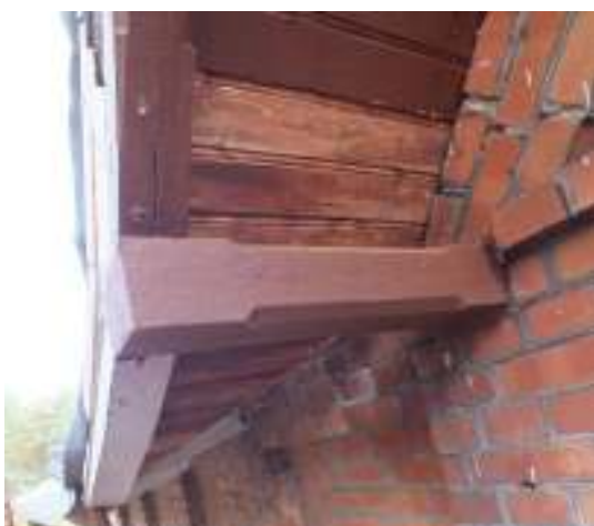
Nya brädor med ursprunglig pärlspontsprofil.
