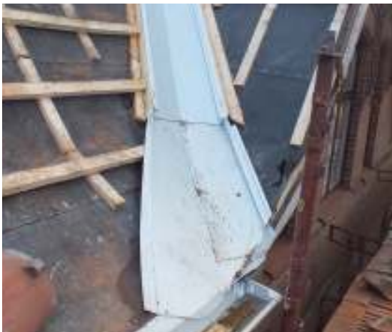
Ränn dalens plåt och avslutning mot hängrännan.
