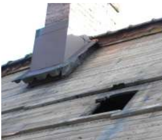
Hål för taklucka intill skorsten.
