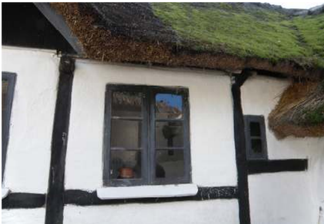
Fig. 7. Boningshuset efter arbetet.
