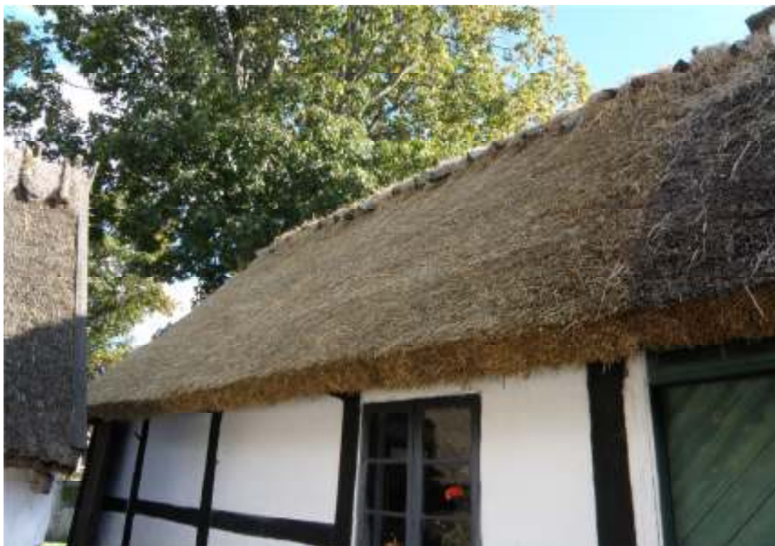
Fig. 2. Boningshuset efter taktäckningen.
