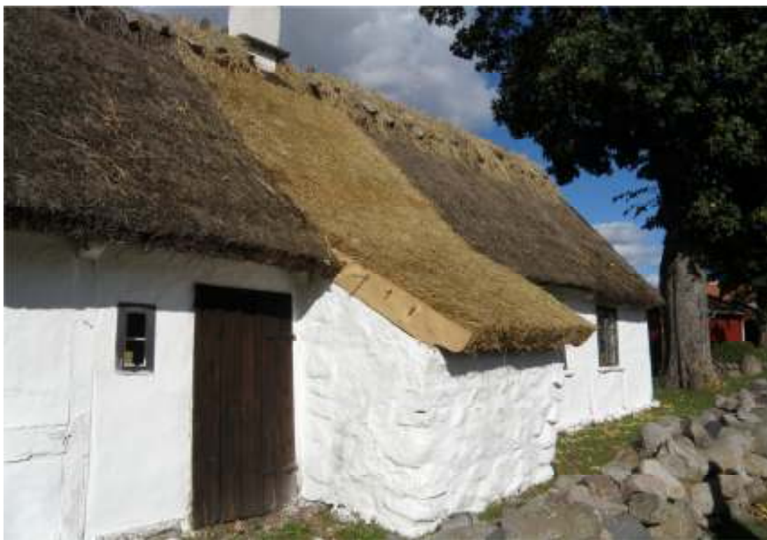
Fig. 3. Bakugnen efter täckning samt de nytillverkade vindskivorna.
