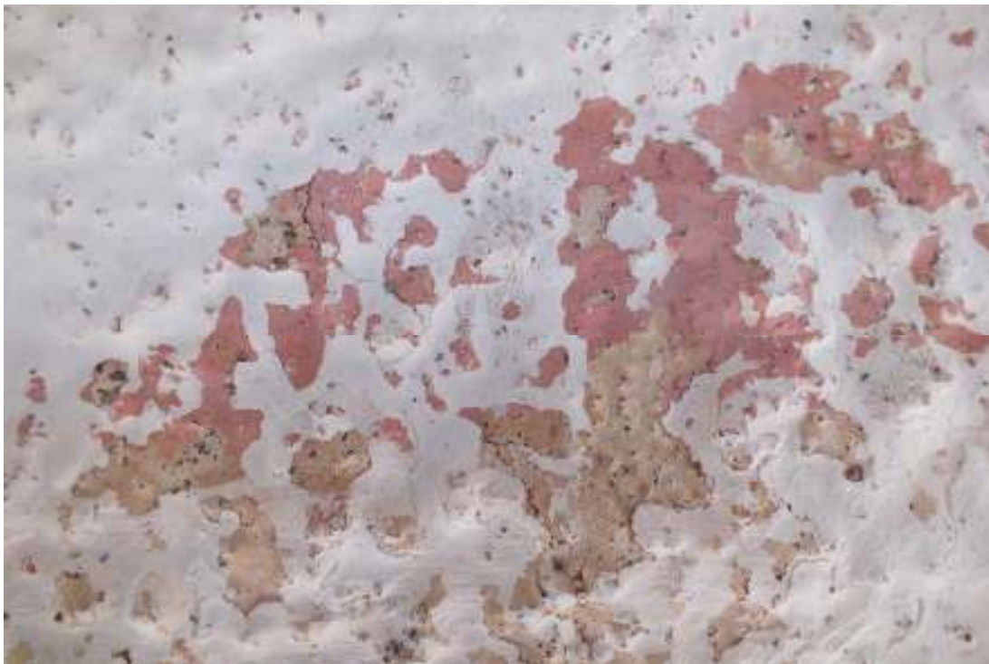
En äldre beige puts fanns under vitkalkningen. Ovanpå putsen syntes rosa anförningar (på listverk/omfattningar).
