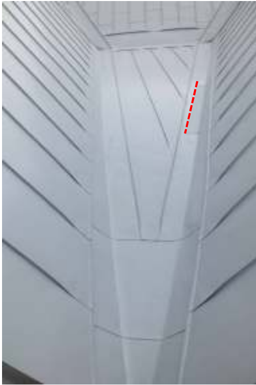
Rännalen efter ommålning. Streckat parti visar den papplagade delen. Till höger syns kyrkans södra dörr efter ommålning.
