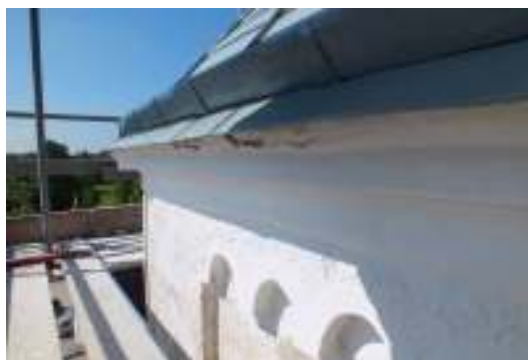
Färgrester på listverken till tvärskeppet innan ommålning. En del putsskador fanns bland annat vid sockeln och i tornets listverk.
