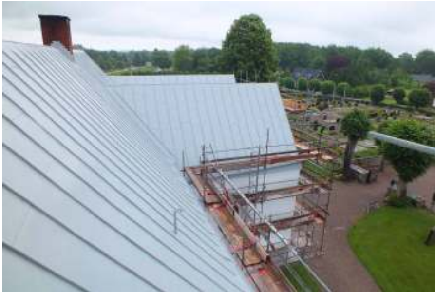
Färdigmålat tak sett mot öster.
