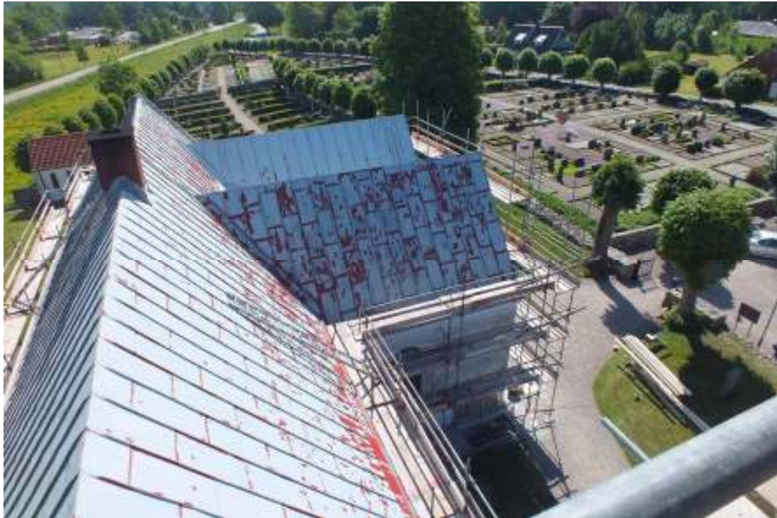
Kyrkans plåttak under renoveringen, sett från tornet.
