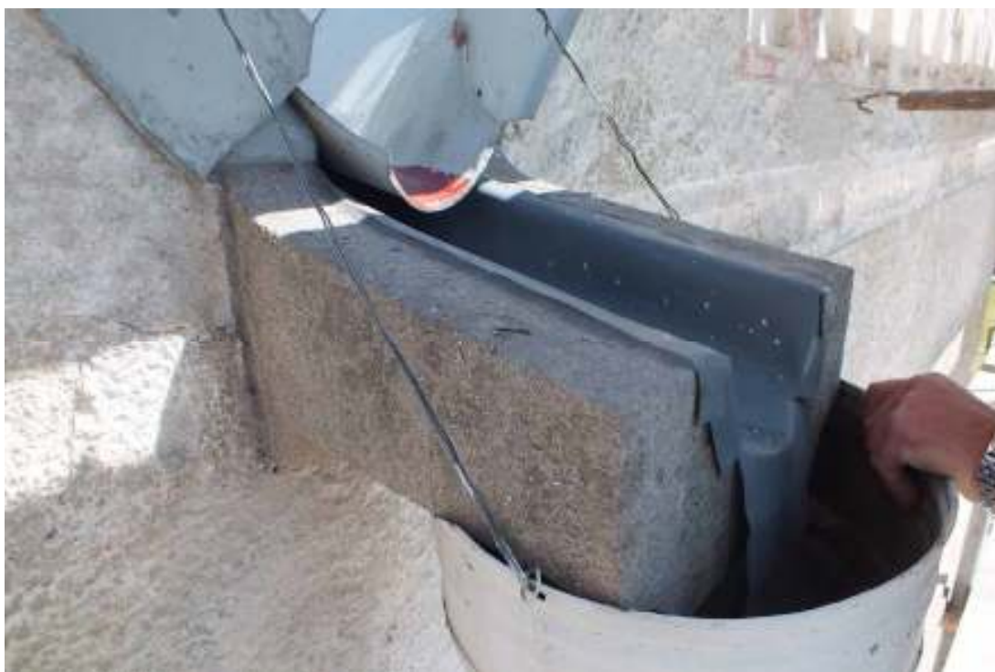
Vattenutkastare i huggen sten i ränn dalen mellan tvärskeppets takfall.
