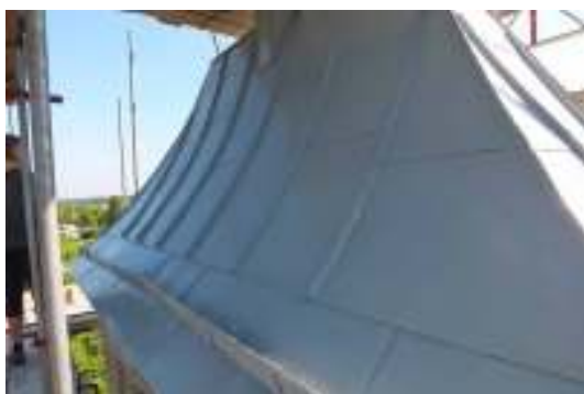
Torntaket efter målning. Till höger syns den gamla färgen till vänster och ny färg till höger.
