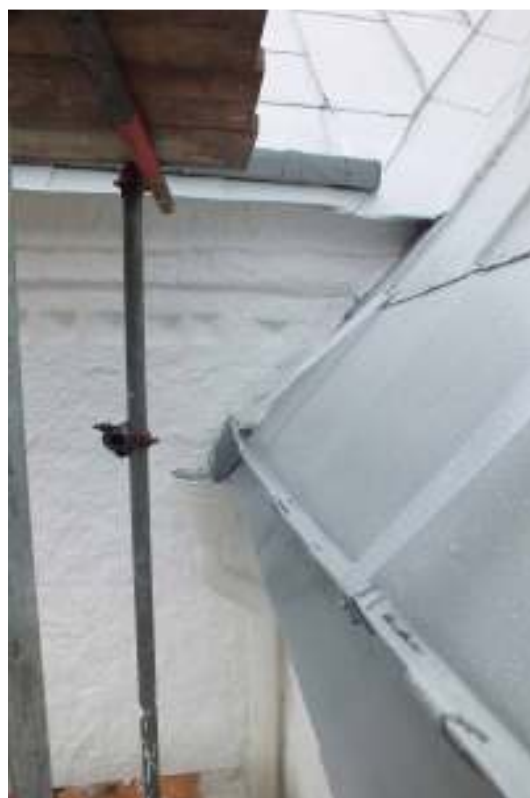
Lagning med asfaltspapp fanns på plåttaket till tvärskeppet. Plåtstag monterades mellan fotrännan och ståndfalsarna för att förstärka rännalen.
