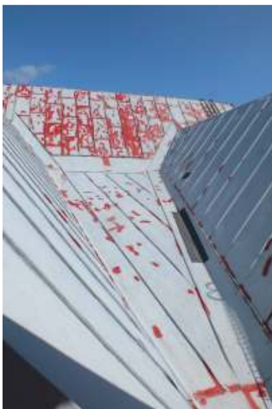
Lagning med asfaltspapp fanns på plåttaket till tvärskeppet. Plåtstag monterades mellan fotrännan och ståndfalsarna för att förstärka rännalen.
