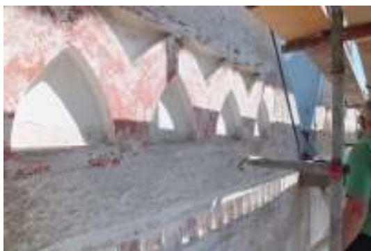
Färgrester på listverken till tvärskeppet innan ommålning. En del putsskador fanns bland annat vid sockeln och i tornets listverk.
