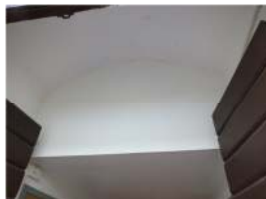
De övre bilderna visar vapenhuset klätt med masonit som var i behov av underhåll. När dörren till det rum som nu rymmer visningsmontern sattes igen kläddes väggar och tak med gips som målades i en äggskalsfärgad kulör. De nedre bilderna visar resultatet.
