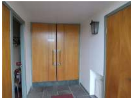
De övre bilderna visar vapenhuset klätt med masonit som var i behov av underhåll. När dörren till det rum som nu rymmer visningsmontern sattes igen kläddes väggar och tak med gips som målades i en äggskalsfärgad kulör. De nedre bilderna visar resultatet.
