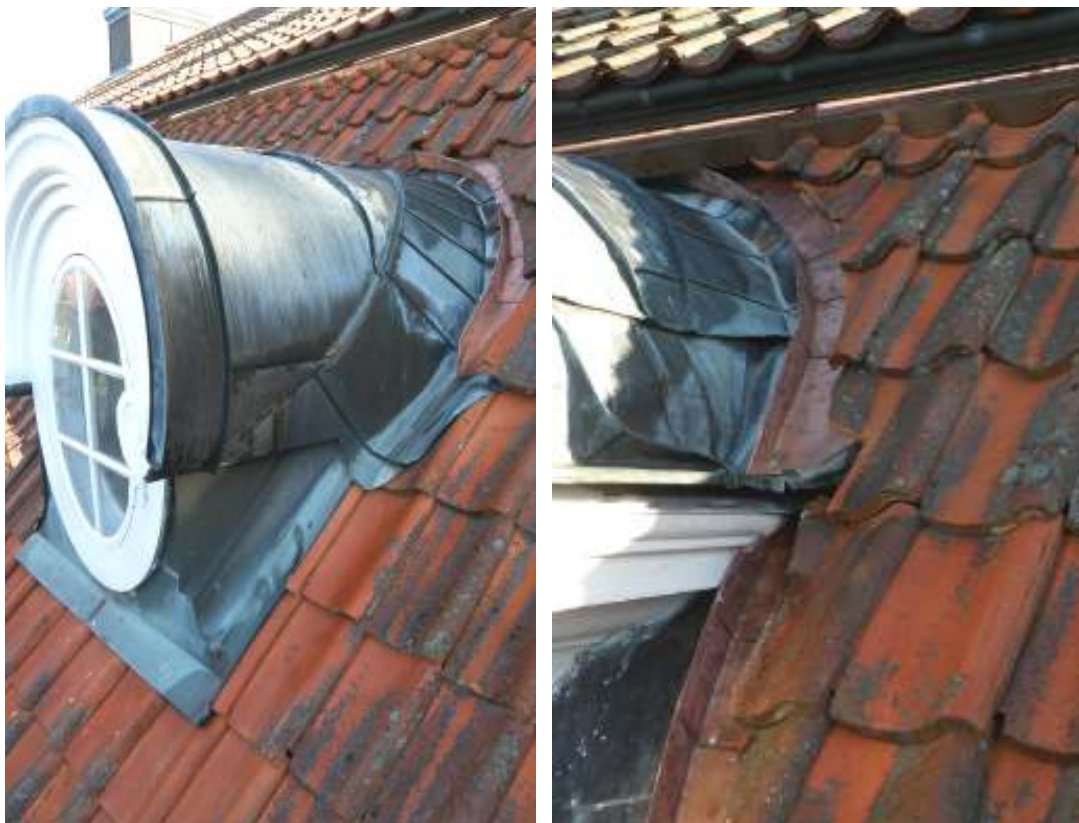
Den vänstra bilden visar hur avrinningen runt kupornas rännalar anordnats, vattnet leds nu förbi dessa genom de nya falsade rännorna. På den högra bilden syns även brottet mellan övre och undre takfall sedan plätinklädnaden kompletterats med ny kopparplåt.
