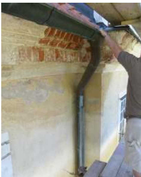
Bilderna visar de skador som krävde mest omfattande putsnedtagning, utmed den västra respektive östra fasaden.
