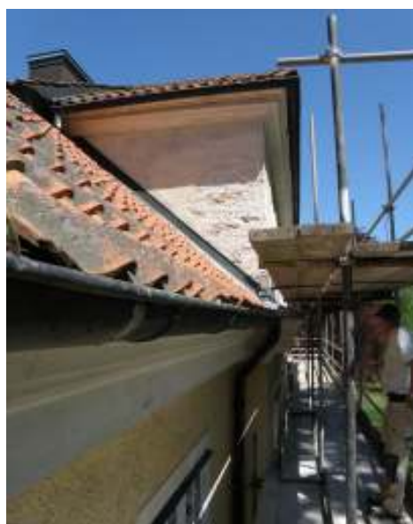
Bilderna visar de skador som krävde mest omfattande putsnedtagning, utmed den västra respektive östra fasaden.
