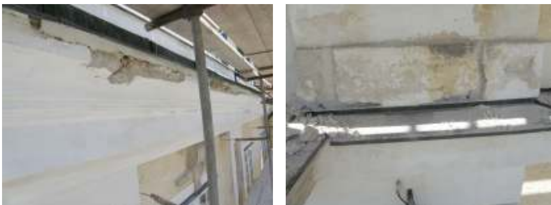
Bilderna visar slätputsade partier som takfotsgesims och rusticering.
