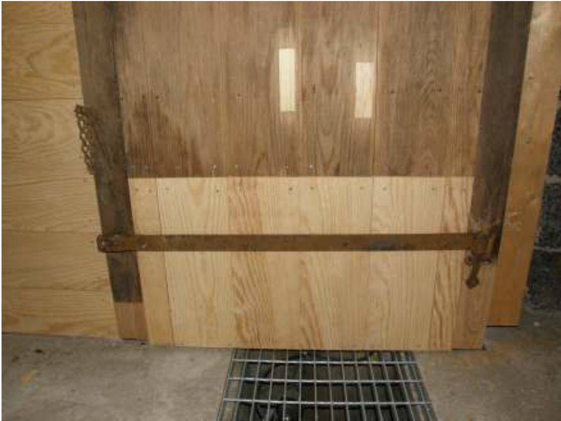
Fig. 12. Södra dörrens lagning.
