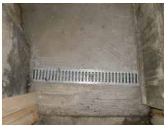
Fig. 3. Vattensluk innanför dörren.
