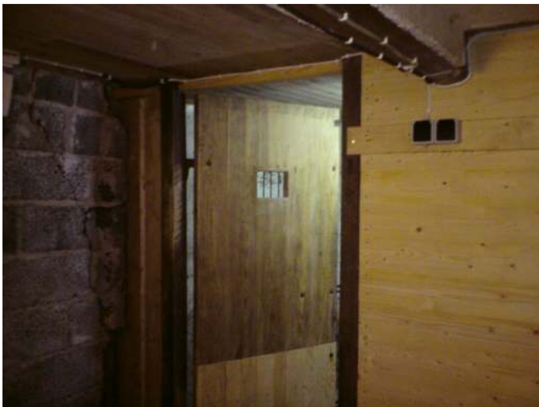
Fig. 16. Anslutningen mellan befintlig lecablockvägg och stolpe.
