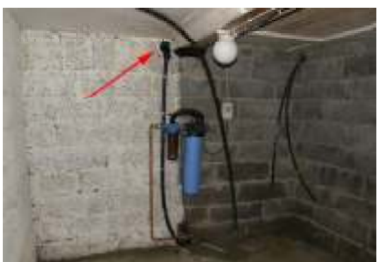
Fig. 4. Vattenavledare genom grundmuren.
