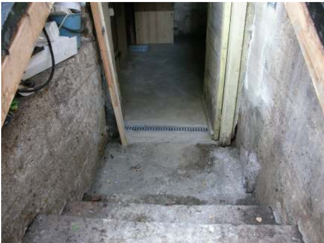
Fig. 19. Vy ner mot källaren, utvisande vattenslukens läge.
