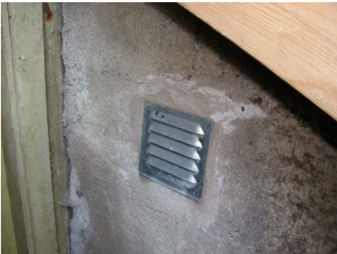
Fig. 15. Ventilen i västra vangstycket, på insidan. En likadan ventil sitter på utsidan.
