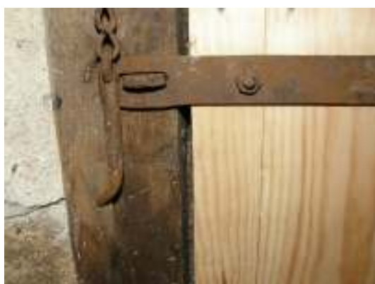
Fig. 7. Återanvänt stängningsbeslag.
