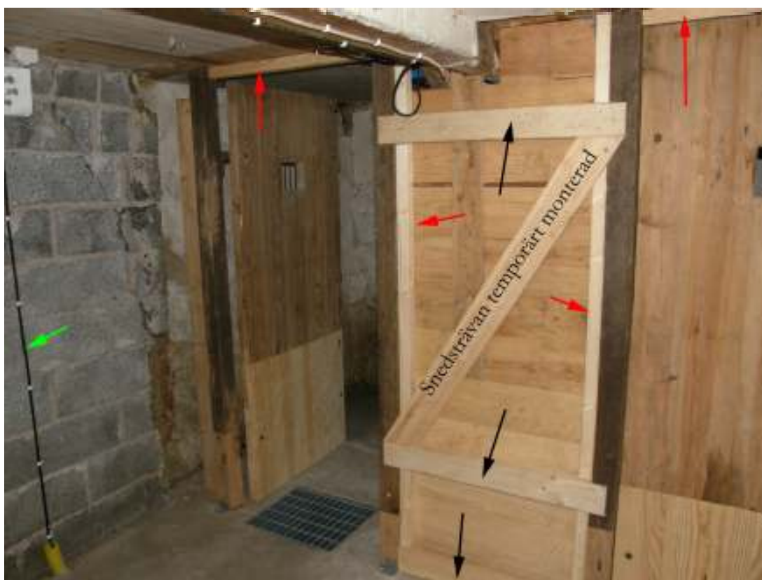
Fig. 8. Röda (2 x 2 ”reglar) och svarta (1 x 4” brädor) pilar markerar nya stöd som säkrar konstruktionen i sidled, grön pil visar nydragen elkabel. Notera gallret till dräneringskasunen och de skarvade stolparna.
