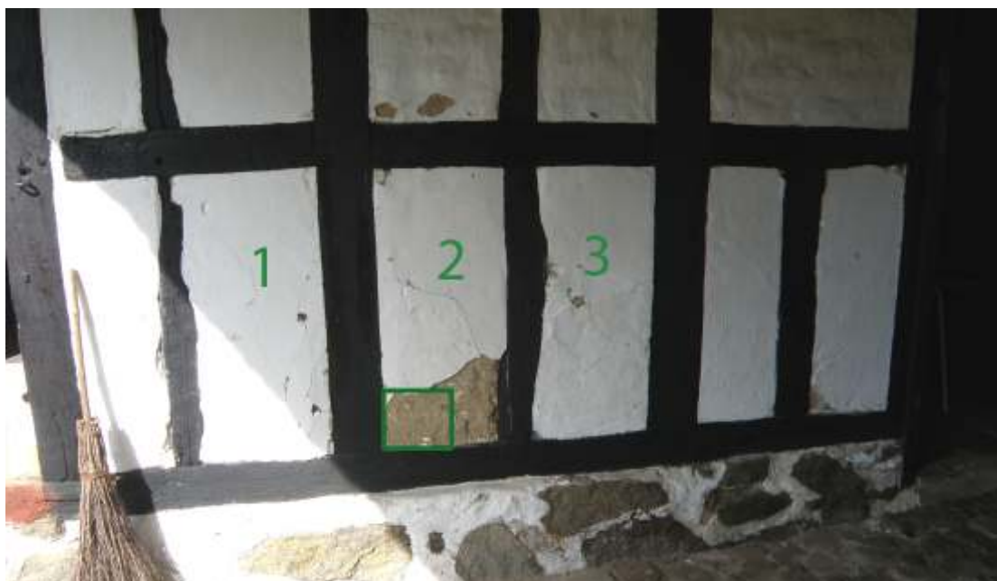
Bilden visar de tre fack på den västra längans västra fasad som har åtgärdats vid årets arbeten. Den gröna rektangeln i fack med nummer 2 markerar en yta som fortfarande är oförändrad. Putsen på detta parti satt väl vid underlaget och har lämnats utan åtgärder med undantag av att ytan har kalkats tillsammans med övriga delar av facket.
