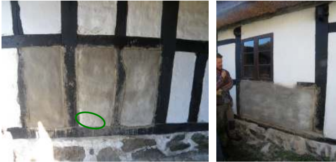
Bilderna visar omputsade fack på den västra respektive södra längan. Den gröna markeringen på den vänstra bilden visar var befintlig putsyta har lämnats orörd och endast kalkats över.
