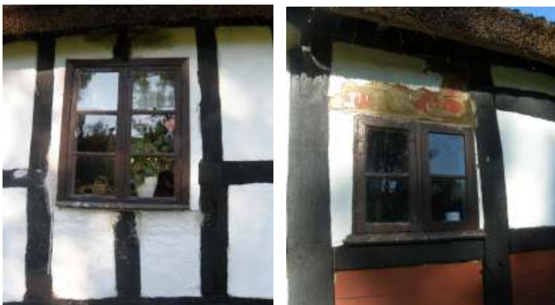
Under fönstret har två mindre ytor på var sida om bistolpen kalkats. Till höger ses den frilagda lerputsens målad med röd slamfärg.
