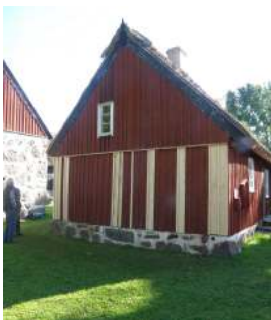
På boningshusets västfasad har panelen setts över och kompletterats, till höger ses hur befintlig panel har återanvänts på en ny plats.
