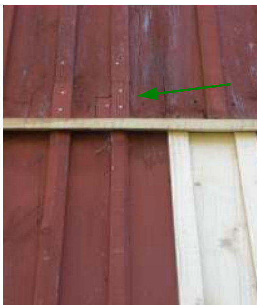
På boningshusets västfasad har panelen setts över och kompletterats, till höger ses hur befintlig panel har återanvänts på en ny plats.
