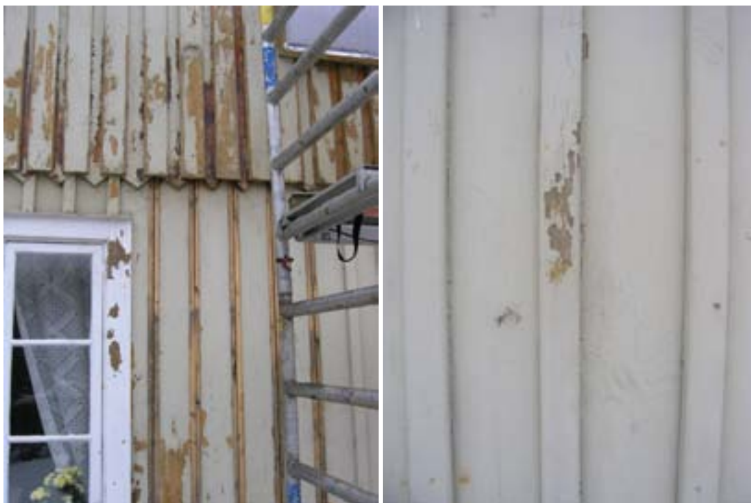
Till vänster pågående färgskrapning av panelen på norra gaveln. Till höger detalj av yta där färgundersökning har genomförts.
