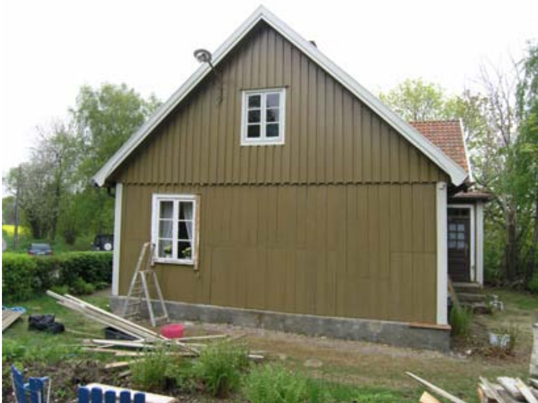
Norra gaveln i slutet av maj 2010. Här har panelen kompletterats med friskvirke och ommålningen är nyligen avslutad.
