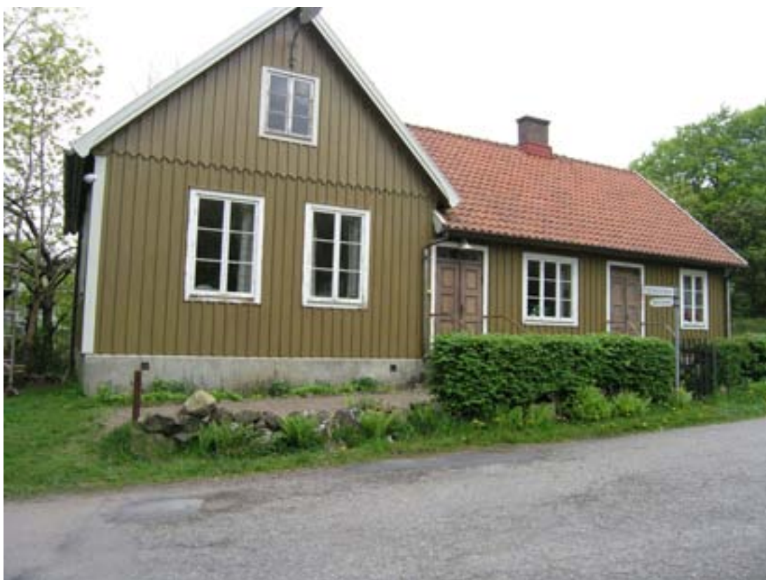
Fasadbilder i samband med slutbesiktningen. Överst den västra fasaden med kökingången. Nederst den östra fasaden med skolentré.
