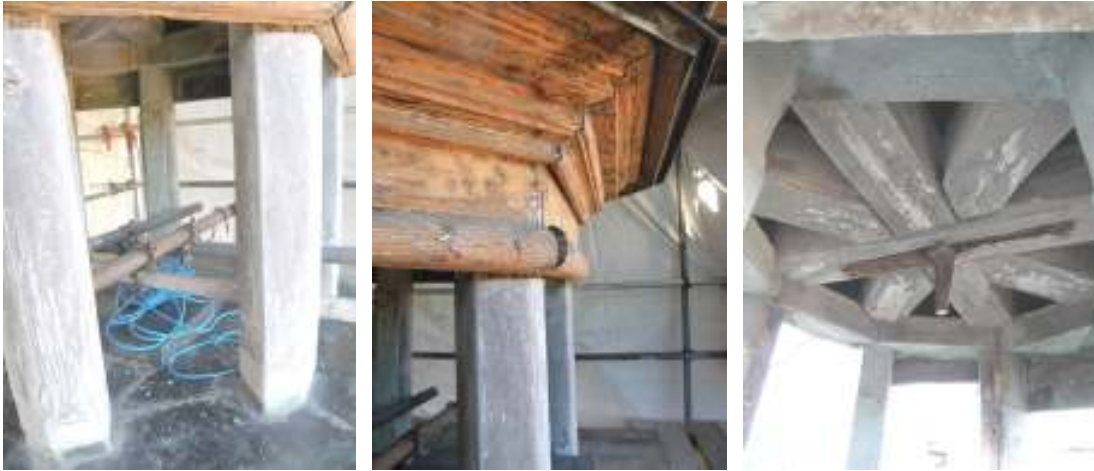
Bilderna visar hur den övre lanterninen ser ut med plåtklädda pelare som bär ett åttkantigt tak med en kraftigt artikulerad takfotslist i trä. Bilden längst till höger visar bjälklaget som håller fast spiran.
