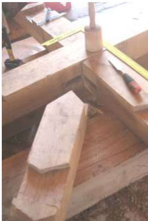
Den vänstra bilden visar det pågående arbetet med tillverkning av ett nytt stjärnbjälklag. På den högra bilden syns pelarna som bär det åttkantiga taket sedan de har klänts in med plåt. Överst i bild skymtar nytillverkad listutsmyckning. Bilderna är tagna av Måleriforma Rose Bergström och son.
