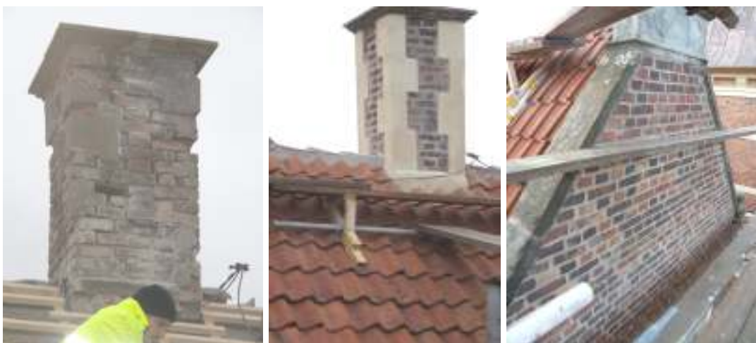
Bilderna visar en av skorstenarna efter rengöring från löst sittande bruk i fogar och utsmyckning samt efter genomförda åtgärder. På bilden längst till höger syns frontespisen efter omfogning.
