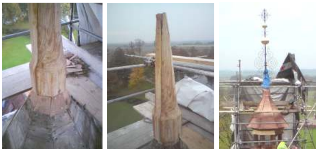
Den vänstra bilden visar spirstockens anslutning mot taket nedanför. På den mellersta bilden syns den del av spirstocken som skall kläs in med plåt, notera det längsgående urtaget för spirans stomme. Bilden längst till höger visar det västra tornet sedan den renoverade spiran har monterats. Här syns också var ny listutsmyckning har lagats i. Bilderna är tagen av Måleriforma Rose Bergström och son.
