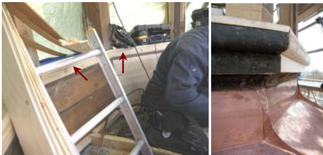
På den vänstra bilden syns äldre panel utmed sargens insida tillsammans med ny. Notera uppbyggnaden av överliggarens baksida, se pil, för fall utåt. På den högra bilden har listan utmed överliggaren kompletterats med en ny del.
