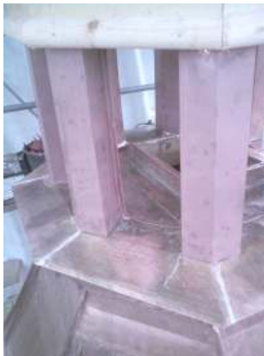
Den vänstra bilden visar det pågående arbetet med tillverkning av ett nytt stjärnbjälklag. På den högra bilden syns pelarna som bär det åttkantiga taket sedan de har klänts in med plåt. Överst i bild skymtar nytillverkad listutsmyckning. Bilderna är tagna av Måleriforma Rose Bergström och son.
