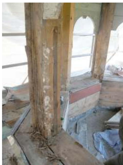
När plåtinklädnaden togs bort visade det sig att flera stolpar hade relativt omfattande rötskador.
