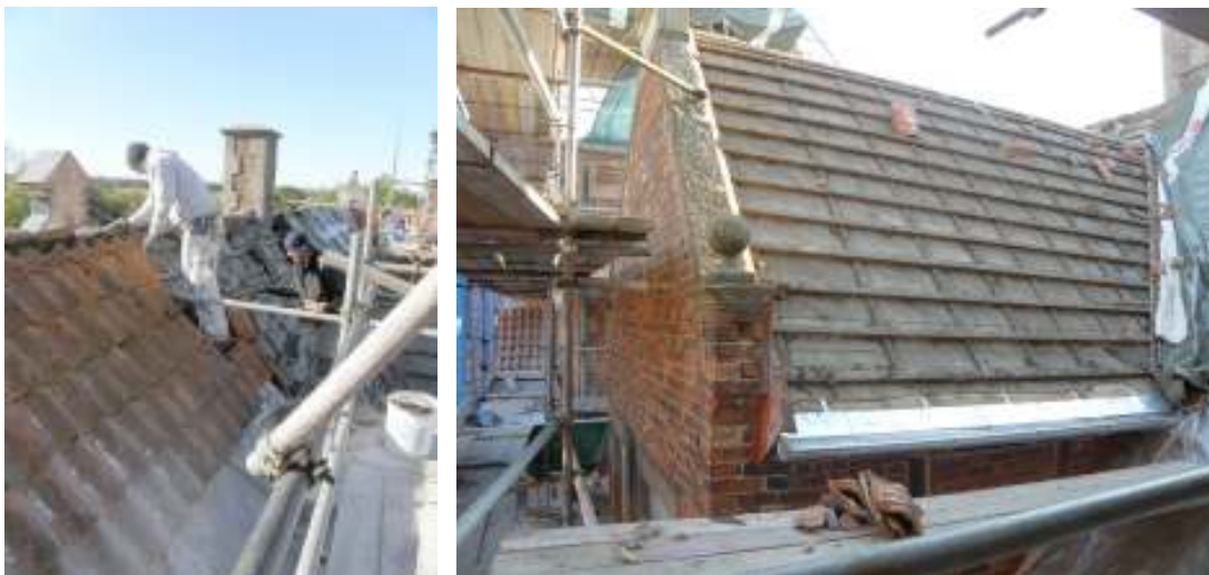
Bilderna visar pågående arbeten med tegeltaken in mot gården.
