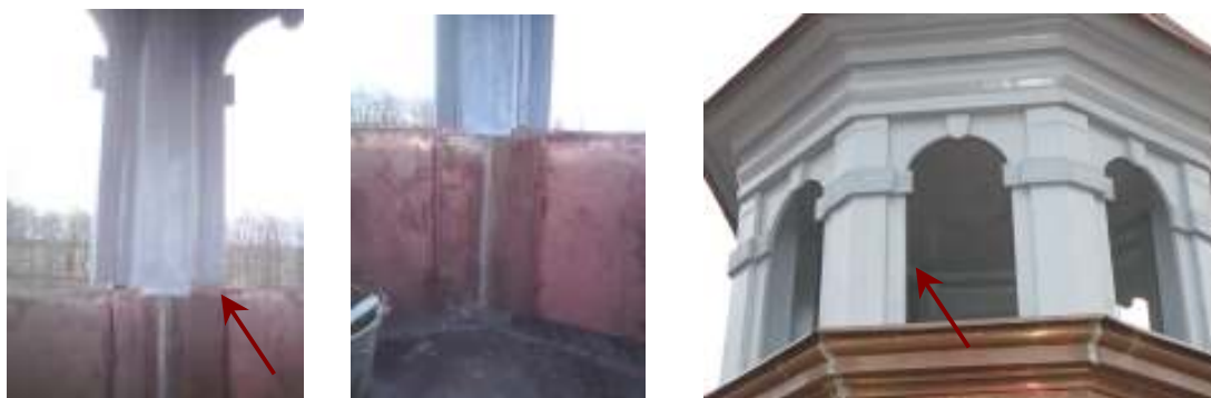
Utsmyckningarna längs pelarnas sidor har tagits av i nederkant och tidigare plåtklädda ytor har försetts med kopparplåt. De två bilderna till vänster är tagna av Måleriforma Rose Bergström och son.
