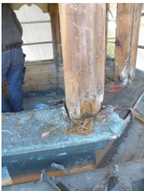
När plåtinklädnaden togs bort visade det sig att flera stolpar hade relativt omfattande rötskador.
