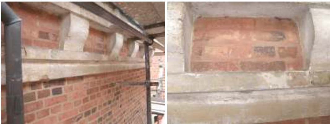
Uppe under takfotens listutsmyckning på det östra tornet upptäcktes vad som såg ut som en tunn rödfärgad slamning utanpå tegelmuren. Även fogarna täcktes av slamningen som såg ut att sitta bäst på dessa ytor. Spår efter vit avfärgning på fogarna kunde inte hittas på de undersökta ytorna.
