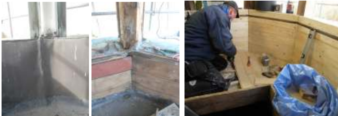
Bilderna visar sargens insida som är plåtklädd och en bild sedan plåten har tagits bort och avslöjar tidigare lagningar med bland annat rödfärgat återanvänt virke. På bilden längst till höger har arbetet med att bygga upp golvet påbörjats.
