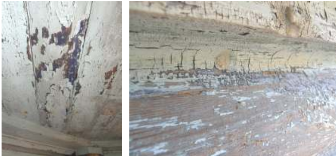
Färgspår som framträdde på det östra tornet på den undre lanterninens innertak samt på takfotslisten.
