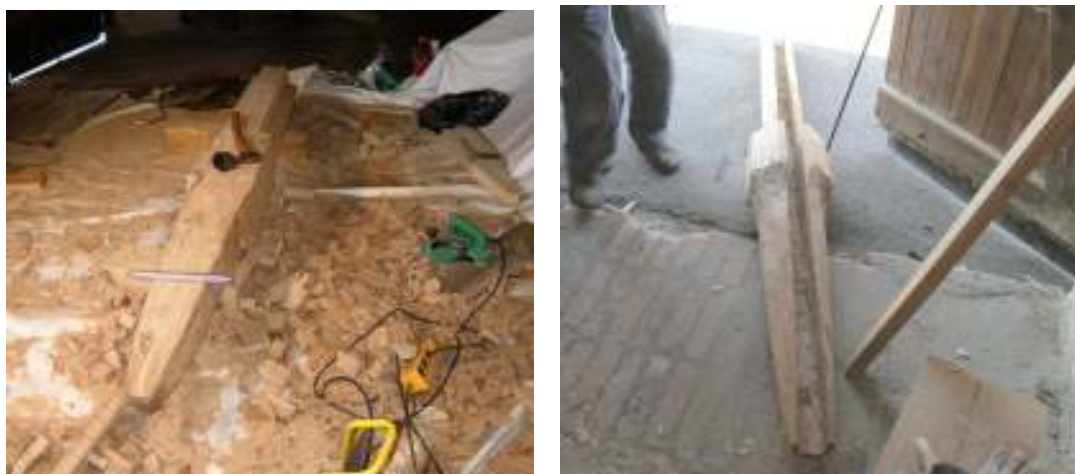
Bilderna visar det pågående arbetet med tillverkning av ny spirstock och det färdiga resultatet.
