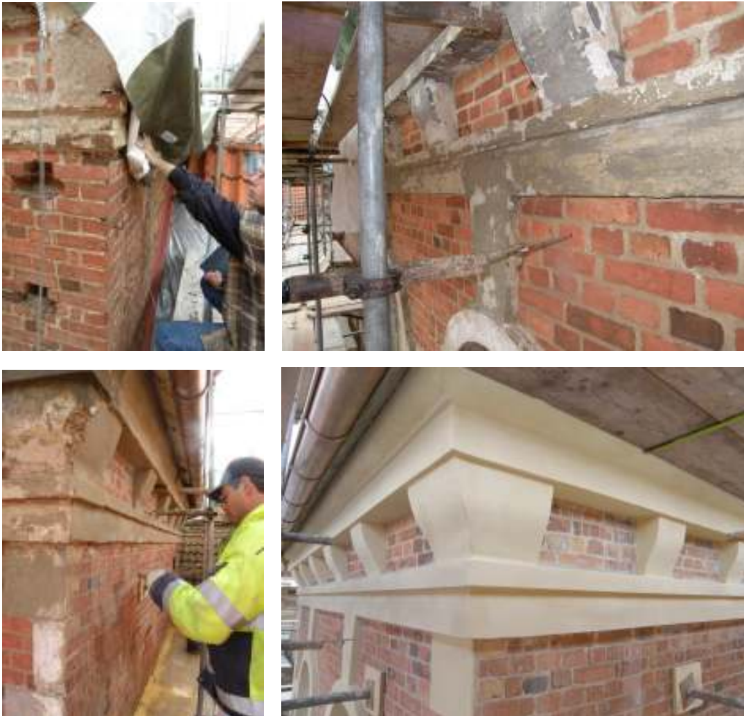
Bilderna visar västra tornet och takfotslistens utseende före, under och efter avslutade arbeten. Den östra respektive norra fasaden avbildas på fotografierna.
