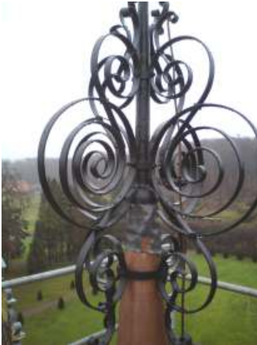
Bilderna visar den östra spiran efter genomförd renovering. På den vänstra bilden syns blyplåten som fungerar som ett isolerande skikt mellan spiran och koppartaket. Bilder tagna av hantverkarna.
