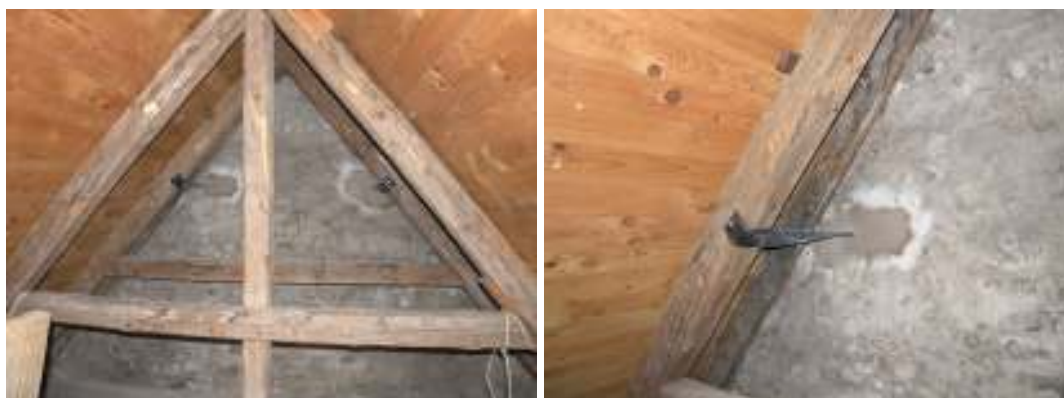
Bilderna visar hur infästning av gavelröstena har gjorts med plattjärn.
