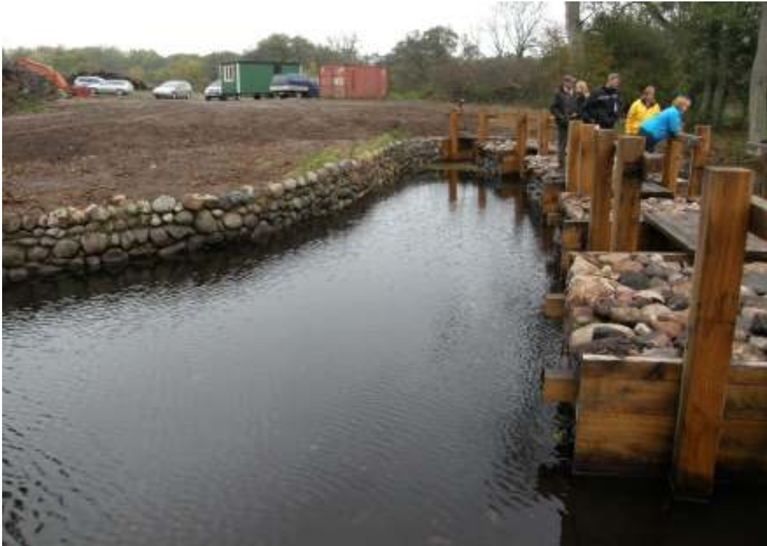
Skovens uppstömssida. Notera stödjemuren, som till sin helhet kunde bevaras.
