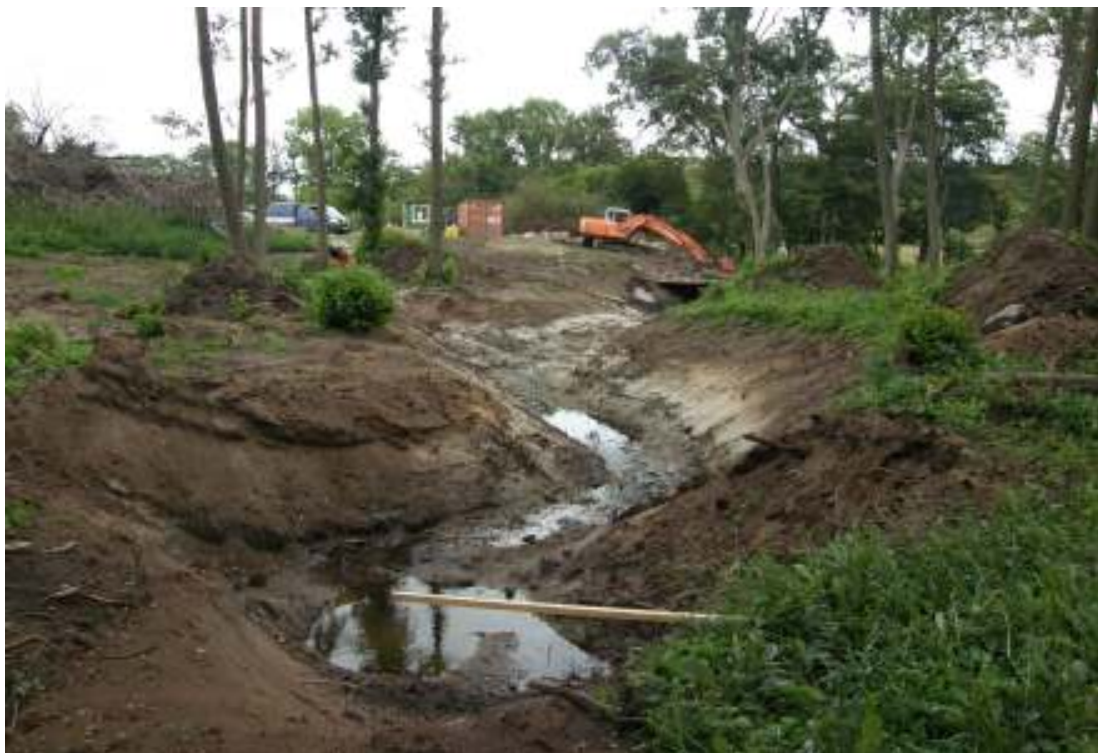
Stigrännan under uppförande.
