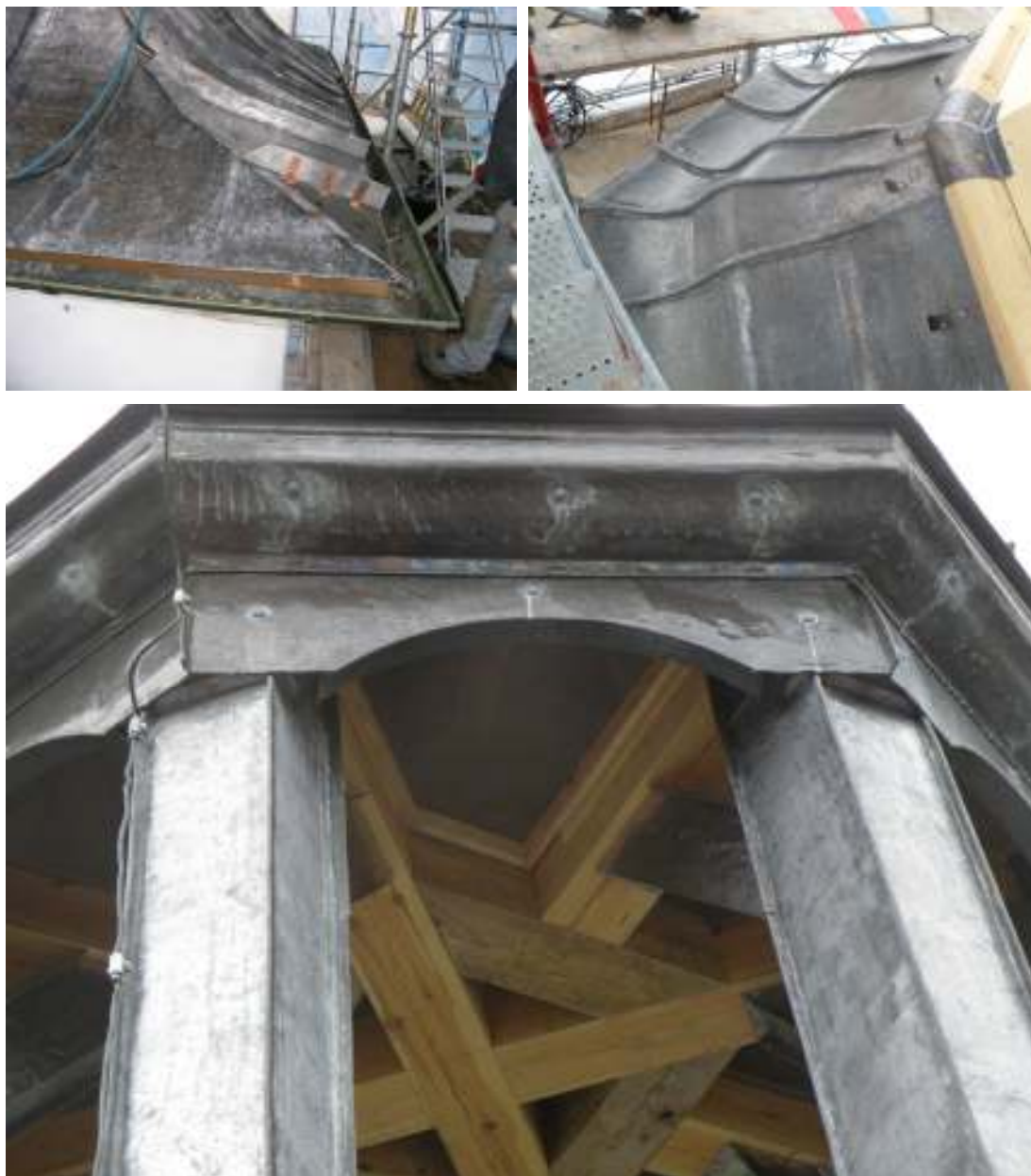
Bilderna överst visar torntaket under blytäckning. Ovan syns lanterninens blytäckta listverk och stolpar efter renovering.
