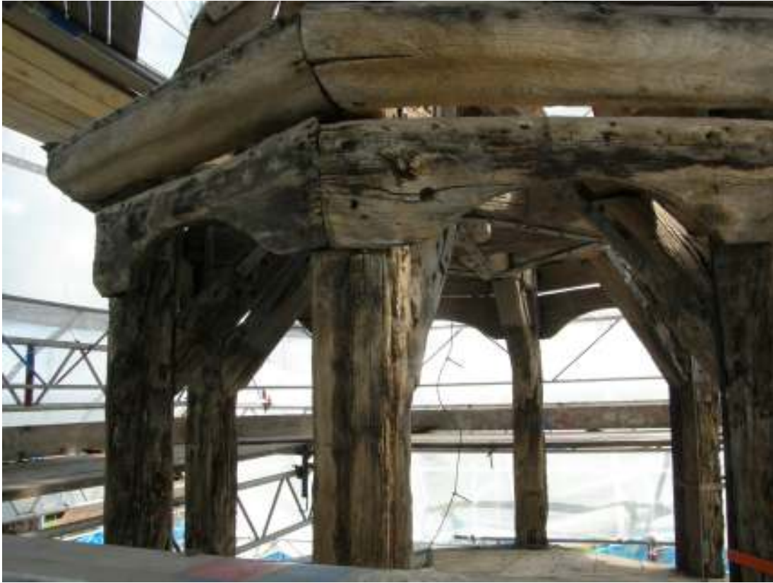
Lanterninens stomme efter borttagning av blytäckning.
