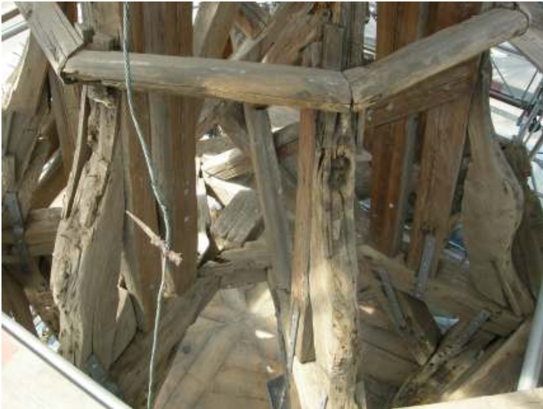
Nedre delen av spirans stomme efter borttagning av blytäckning.
