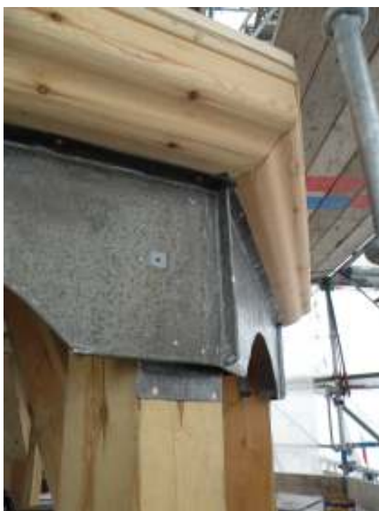
Spårspetsen och stora delar av stommen var angripen av röta. Överst syns sydvästra hörnet av torntaklaget. Bilden överst till höger visar spårspetsens stomme efter borttagning av blytäckningen. Bilden i mitten till vänster: Lanterninens rötskadade stomme demonteras. I mitten till höger: Torntaklagets nedre stomme under renovering. Nederst till vänster: Tornspirans nytillverkas. Nederst till höger: Detalj av lanterninens profilerade listverk före blytäckning.
