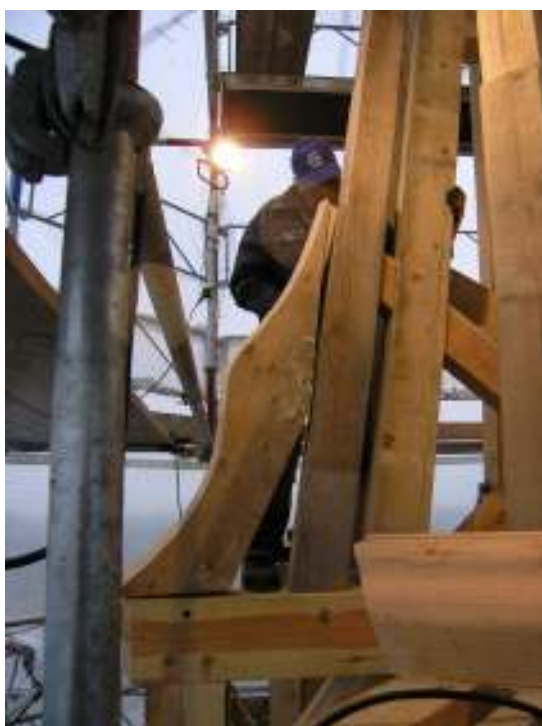
Spårspetsen och stora delar av stommen var angripen av röta. Överst syns sydvästra hörnet av torntaklaget. Bilden överst till höger visar spårspetsens stomme efter borttagning av blytäckningen. Bilden i mitten till vänster: Lanterninens rötskadade stomme demonteras. I mitten till höger: Torntaklagets nedre stomme under renovering. Nederst till vänster: Tornspirans nytillverkas. Nederst till höger: Detalj av lanterninens profilerade listverk före blytäckning.
