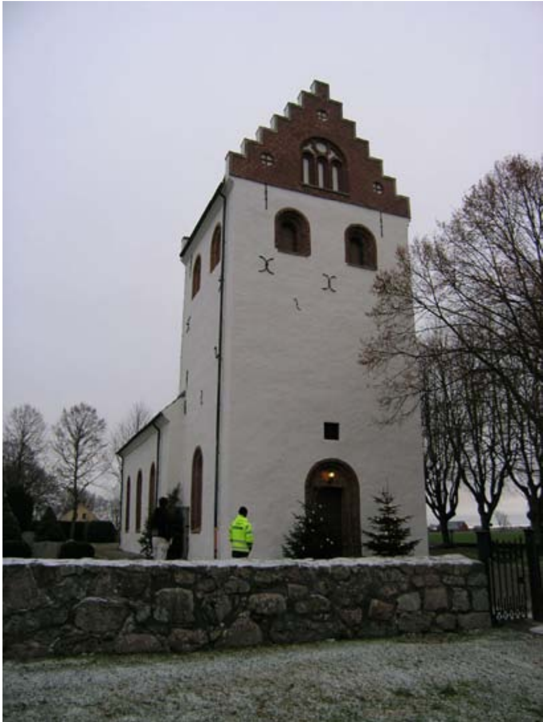
Kyrktornet, sett från väster under slutbesiktningen i december 2009
