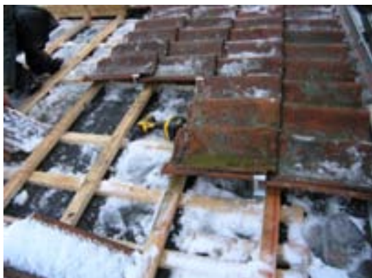
Befintligt taktegel tas ner
