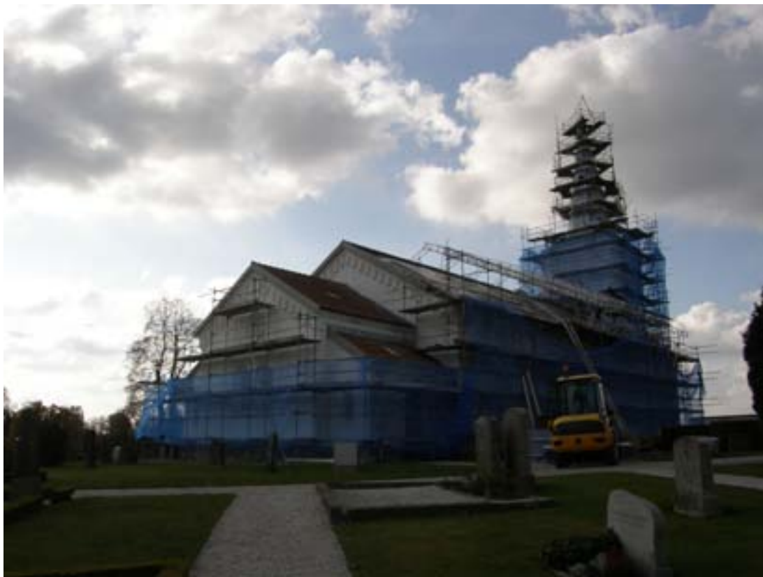
Kyrkan sedd från nordost under renoveringsperioden
