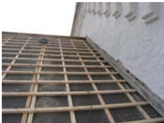
Det lägra takfallet under byggtiden
