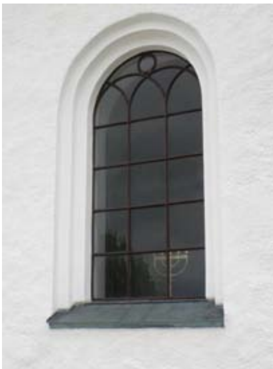
Fönster efter renoveringen
