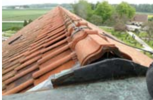
Befintlig taktäckning på långhuset
