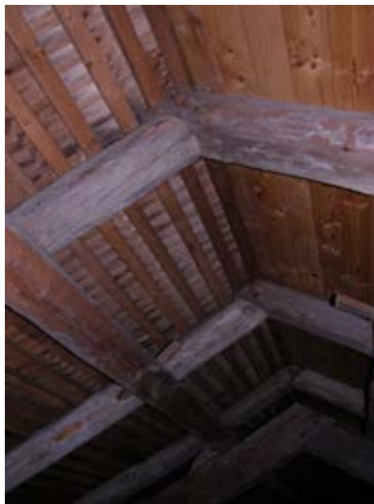
Kyrkans lägre takfall med spontade brädor i norr och stickor i söder
