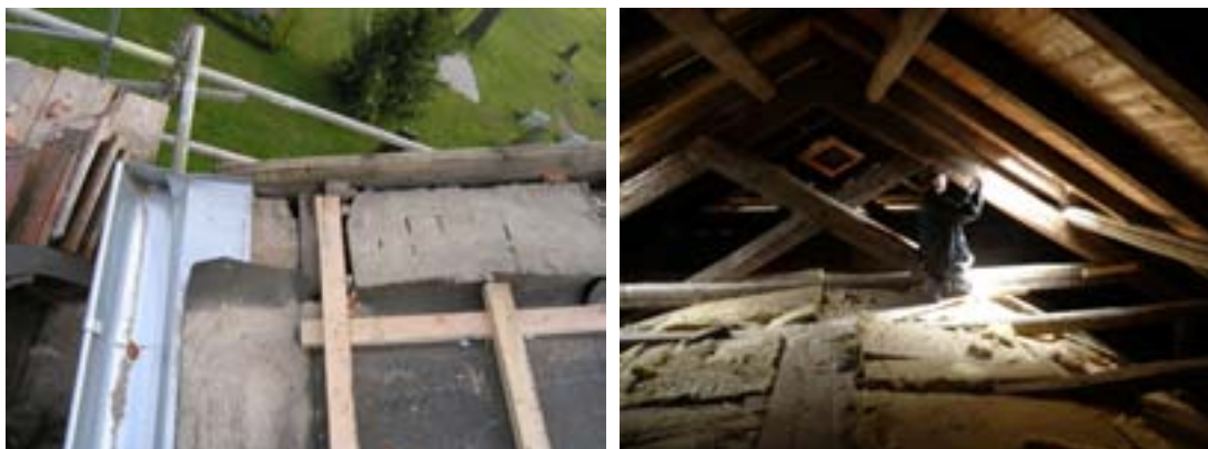
Nya hänger, ny papp och läkt på takets lägdellarna ”Underarbete” på kyrkvinden
