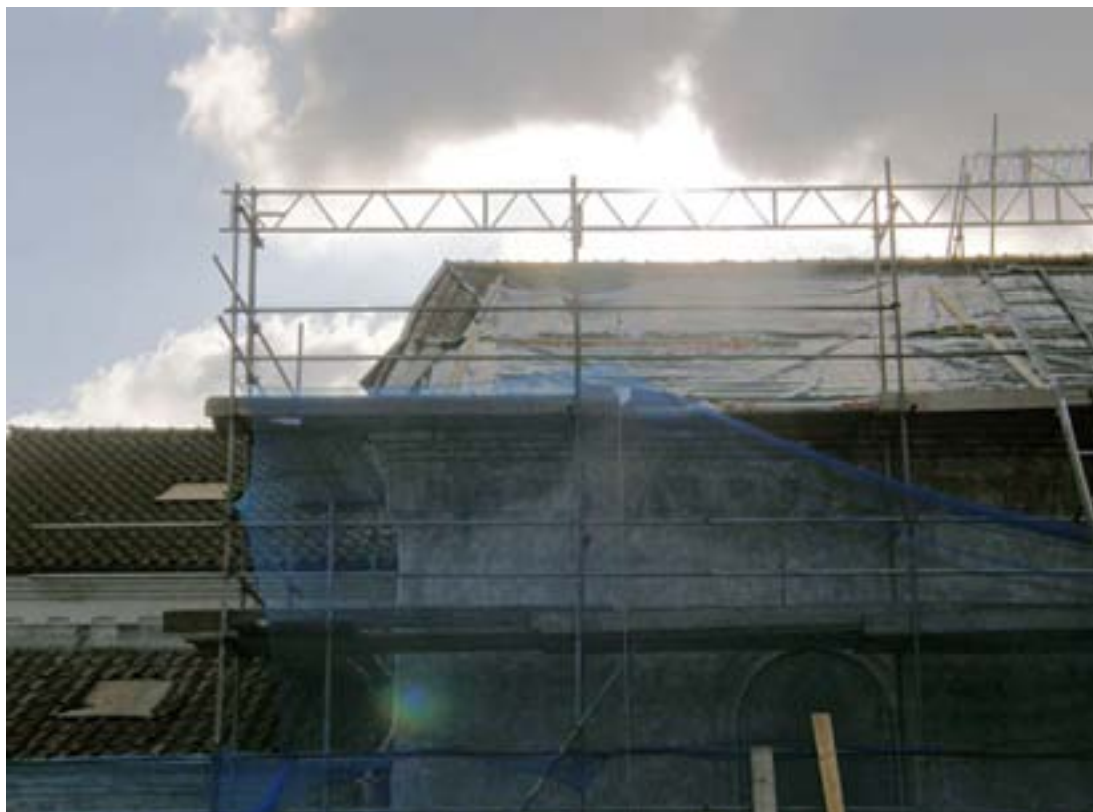
Kyrkans norra takfall under renoveringen
