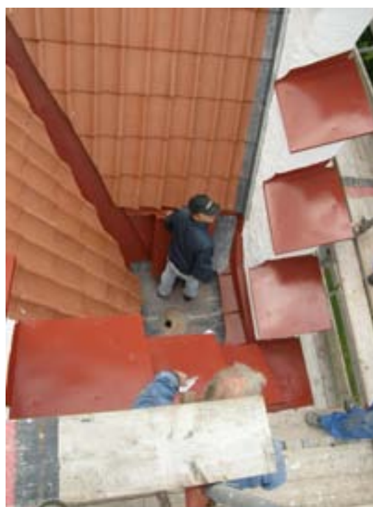
Bild 9-11. Överst: Torntinnarna förhöjs och muras om. Nedtill visas del av torntaket före (till v.) och efter renovering (till h.). Mitt i bilderna syns brunnar för vattenavledning.
