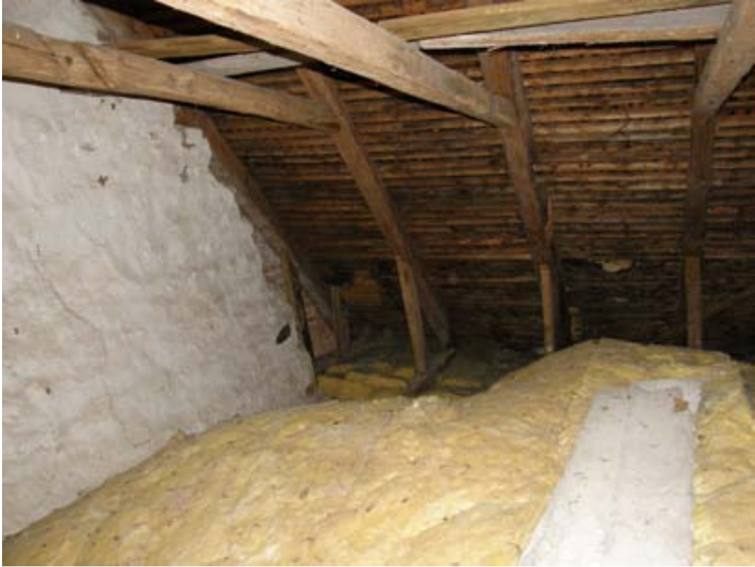
Bild 21. Inslag av medeltida takstolsvirke fanns på korvinden. Upptill i bild syns banband med äldre urtag. Från norr.
