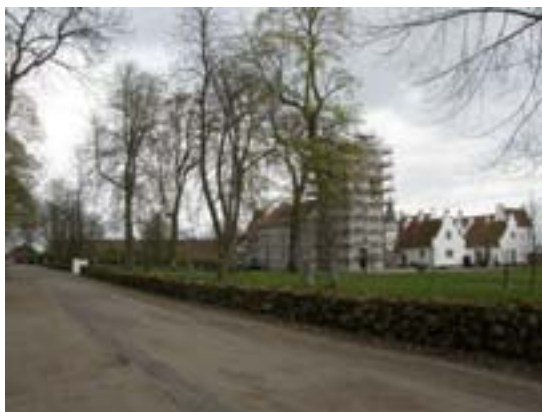
Bild 3. Kyrkan under renovering i april 2009.
