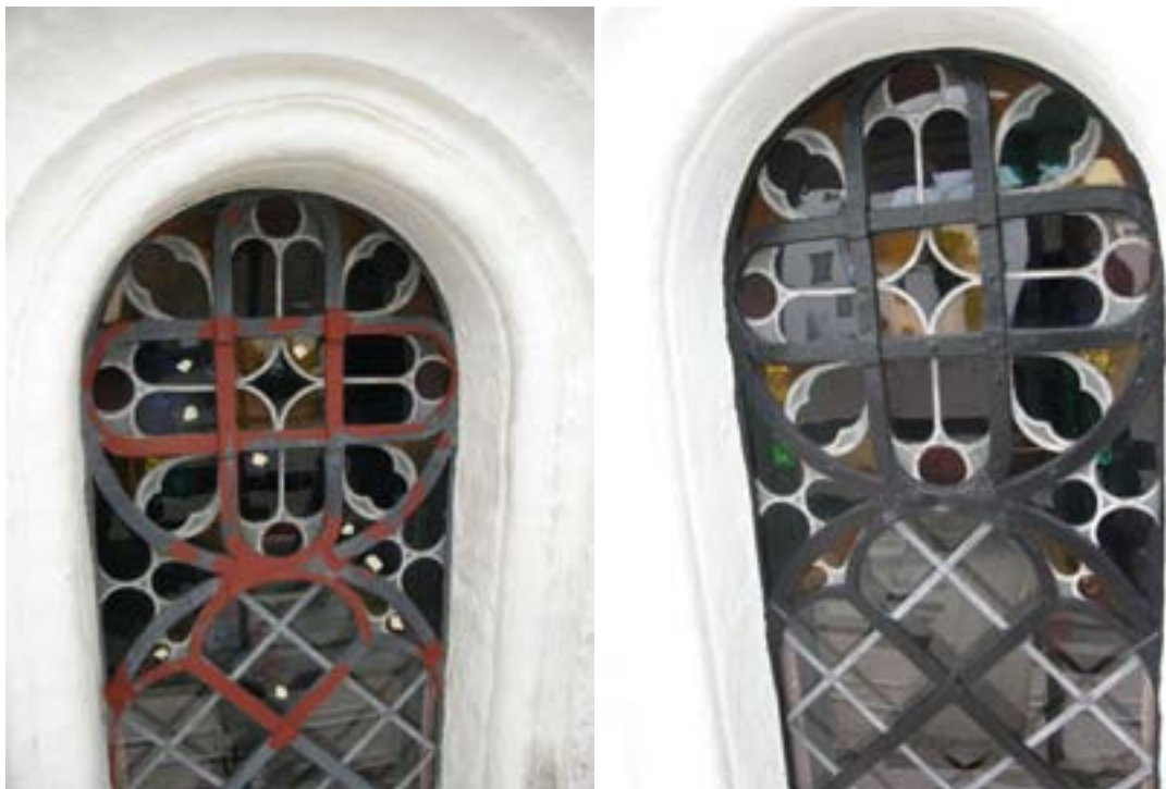
Bild 19-20. Ett av kyrkans fönster under renovering (till v.). Tejpbitarna markerar glas som skulle lagas. Den högra bilden visar ett av fönstren efter renovering.
