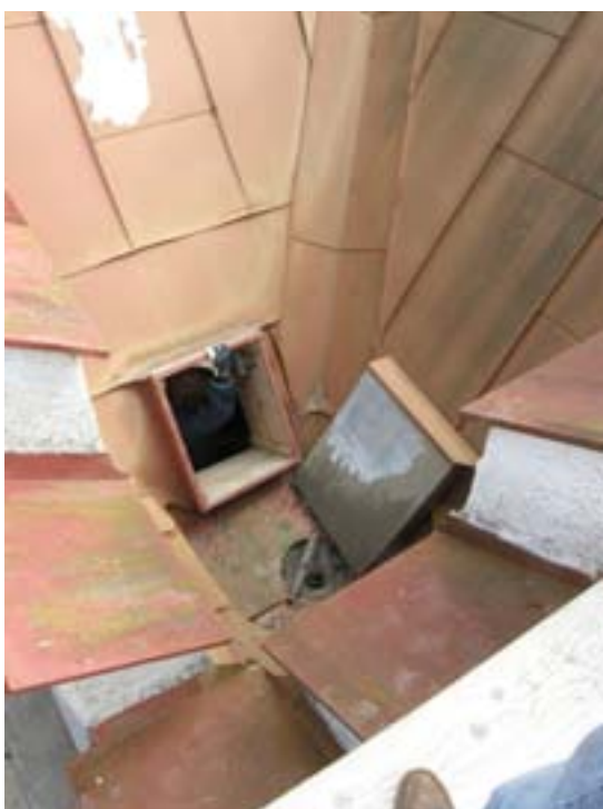
Bild 9-11. Överst: Torntinnarna förhöjs och muras om. Nedtill visas del av torntaket före (till v.) och efter renovering (till h.). Mitt i bilderna syns brunnar för vattenavledning.
