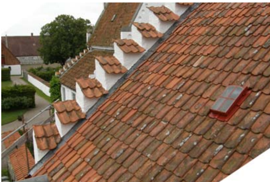
Bild 16. Kortaket efter renovering och montering av nytt takfönster. Norra takfallet.
