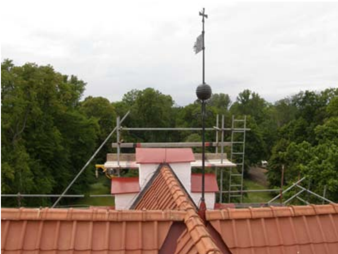
Bild 12-14. Överst till v.: Nytt tegeltak läggs ovanpå det gamla plåttaket. I bilden överst till höger syns anslutning från en av takets brunnar till hängränna. Nederst syns det färdigrenoverade torntaket uppifrån. Tinnarna är uppmurade och avtäckta, krönkorset målat och tegeltaket har kommit på plats. Vinkelrännorna är av rödmålad plåt.
