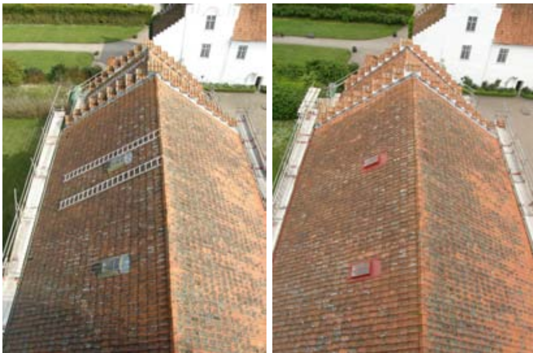
Bild 5-6. Långhustaket före (till v.) och efter renoveringen (till h.). Sett från väster.
