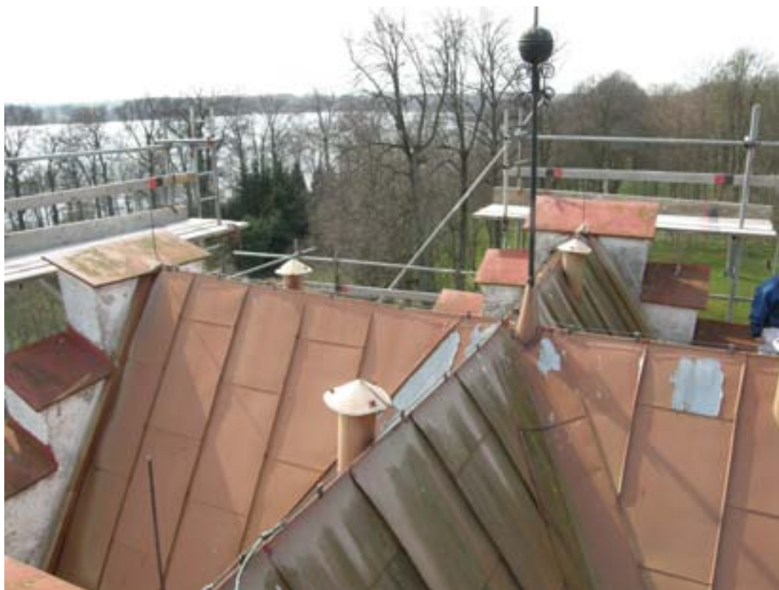
Bild 4. Torntaket före renovering i april 2009.
