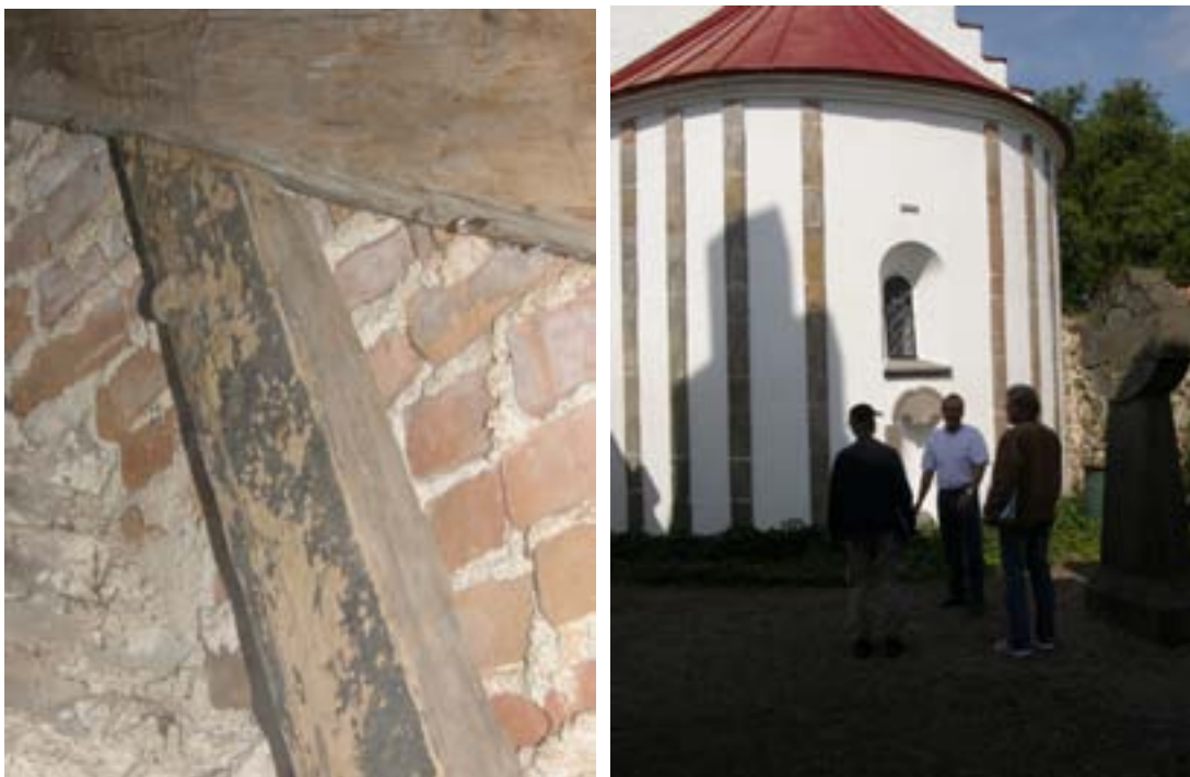
Bild 22-23. På korvinden iaktogs ett stödben med svart avfärgning ev. tjärsmålning. Korvindens sydöstra hörn. Den högra bilden visar den färdigrenoverade absiden i juni 2009.
