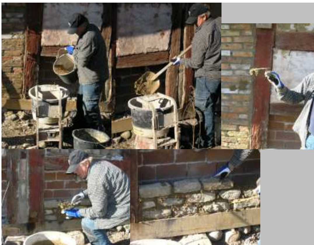
Murarbete på korsvirkeskonstruktionen. Lera och sand blandas med vatten till rätt konsistens, ca 1 del lera på 3 delar sand. Återvänt lertegel muras åter in i konstruktionen för att sedan putsas över med lerbruk som görs något fetare.
