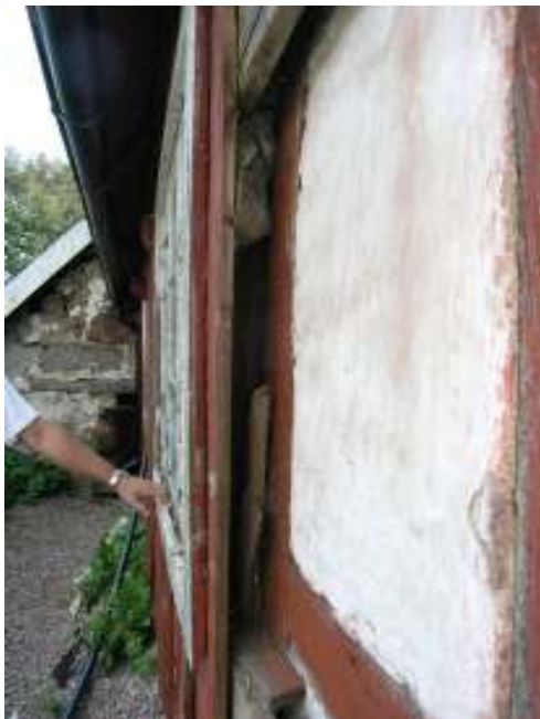
Panelen har fungerat som skydd för väder och vind under en tid då byggnaden stod utan användning och underhåll. Nu har den gjort sitt och korsvirket tas fram för restaurering.
