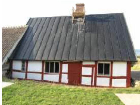
Östra fasaden efter restaurering (fönsterbågar uttagna)
