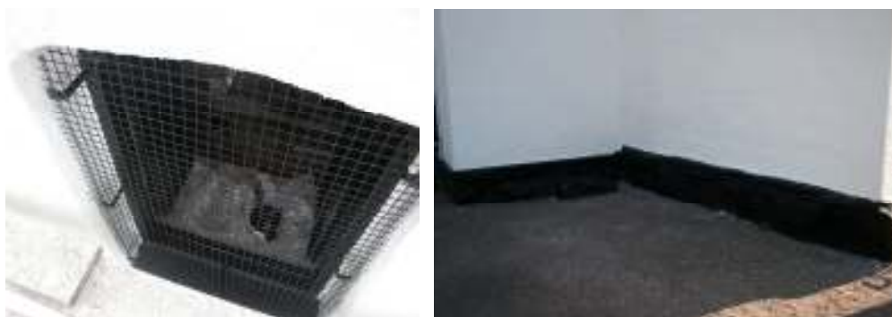
Bilder ovan: Tornluckans metallgaller (till vänster) och tornets sockel (till höger) efter renovering.
