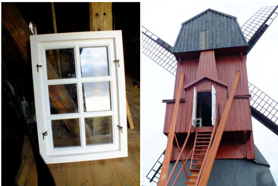
Malmbergs Snickeri tillverkade nya fönster av tätvuxen fur enligt måtten på de befintliga. Fönstren har sedan målats med vit linoljefärg. Till höger: den uppbrutna panelen återställdes likt befintlig och målades med oljealkyd i samma röda kulör.
